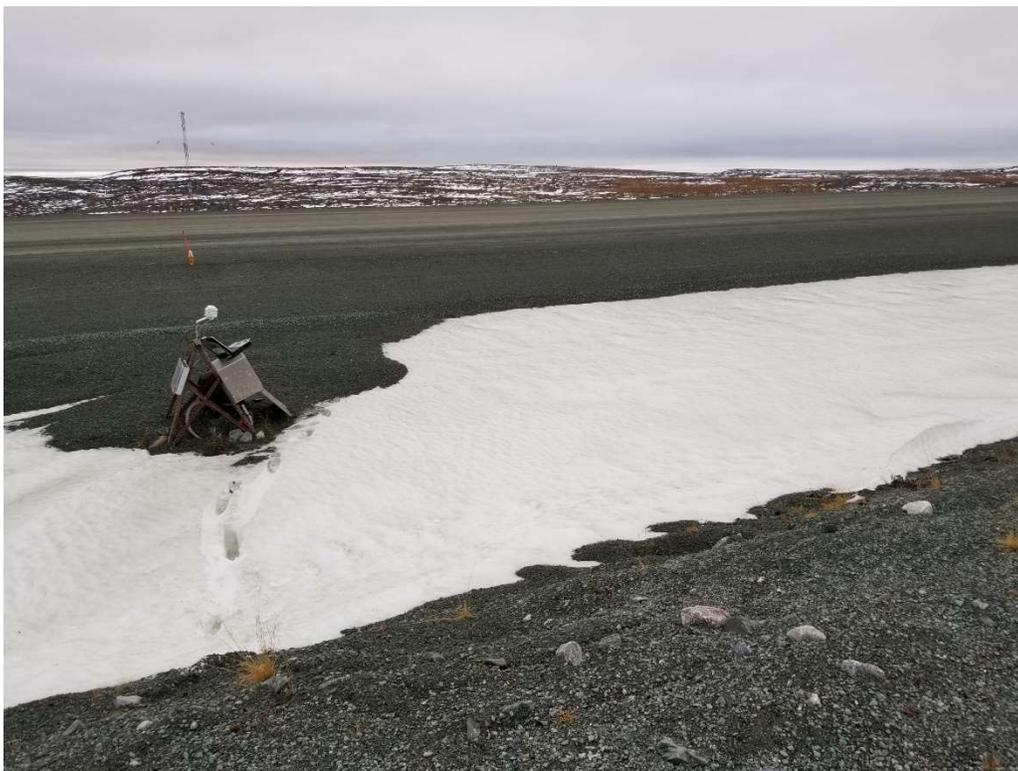
**Figure 19** Présence de neige accumulée dans le fossé de drainage à proximité du câble KANGIR-F2B.
