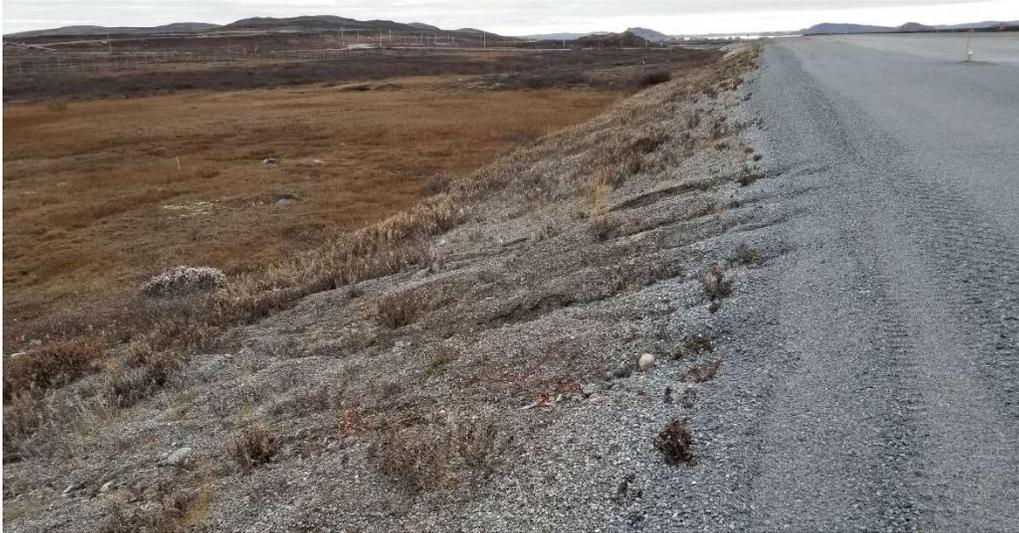
**Figure 23. Tassement différentiel transversal à la piste et rigoles aux environs du chaînage 5+250 à environ une cinquantaine de mètres du câble HT-181**
