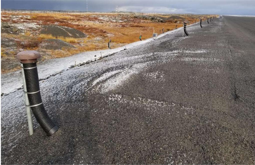
**Figure 9. Présence d'eau en pied de remblai à proximité du câble PUV-F5**
