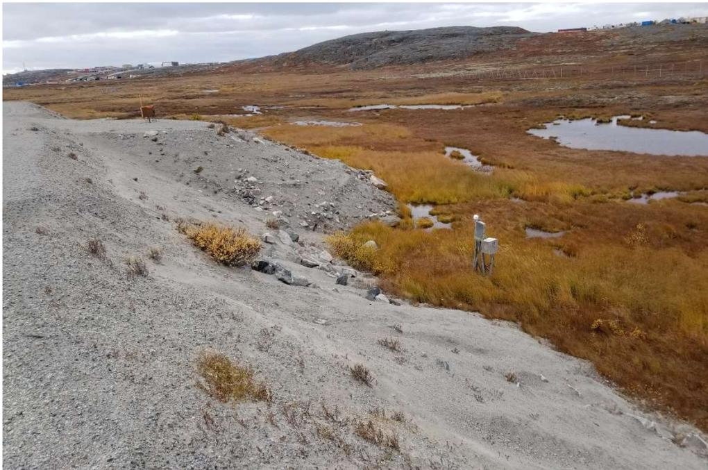
**Figure 4. Présence d'eau en pied de remblai et dans le terrain adjacent au câble INU-F2**
