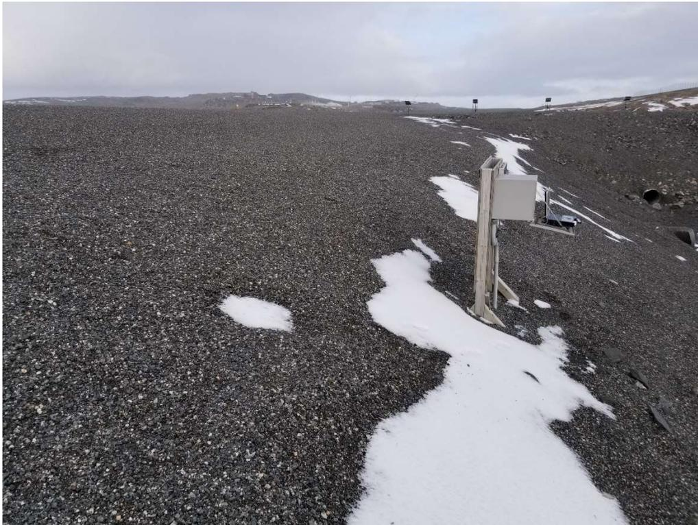
**Figure 16. Aucune dégradation de la piste et du rebord du remblai à proximité du câble SAL-F3**
