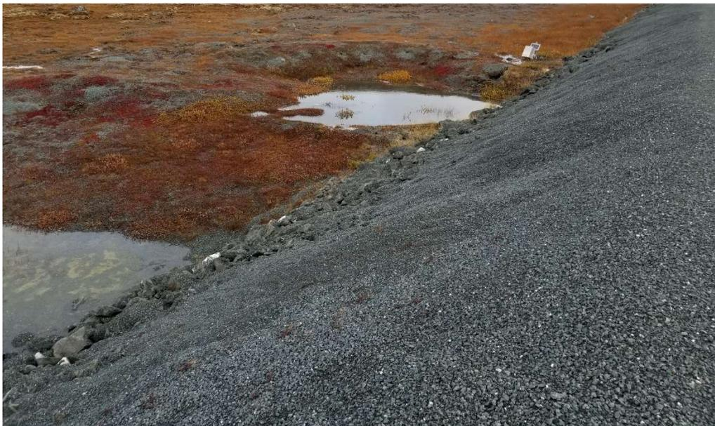
**Figure 14** Présence d'eau en pied de remblai à proximité du câble AKU-F2.
