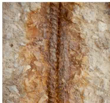
(b) Renfort rouillé apparent dans un élément de structure, avec une réduction négligeable de la section de renforcement.
