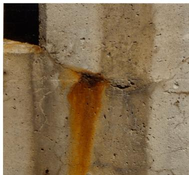
(a) Tache de rouille sur un élément structurel en béton.
