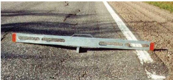
3. La fissuration s'accroît et d'autres bris apparaissent en surface.
