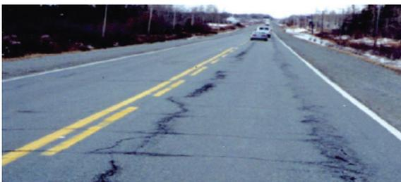
Chaque chaussée se comporte différemment selon, entre autres, la nature des sols, la position de la nappe phréatique, l'épaisseur des couches, le climat, le type de chaussée, sa géométrie, les caractéristiques des matériaux de construction, le trafic. Il faut donc considérer tous ces paramètres pour diagnostiquer adéquatement les causes de détérioration.
