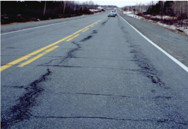
Chaque chaussée se comporte différemment selon, entre autres, la nature des sols, la position de la nappe phréatique, l'épaisseur des couches, le climat, le type de chaussée, sa géométrie, les caractéristiques des matériaux de construction, le trafic. Il faut donc considérer tous ces paramètres pour diagnostiquer adéquatement les causes de détérioration.
