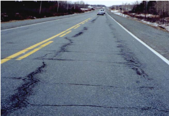
Chaque chaussée se comporte différemment selon, entre autres, la nature des sols, la position de la nappe phréatique, l'épaisseur des couches, le climat, le type de chaussée, sa géométrie, les caractéristiques des matériaux de construction, le trafic. Il faut donc considérer tous ces paramètres pour diagnostiquer adéquatement les causes de détérioration.
