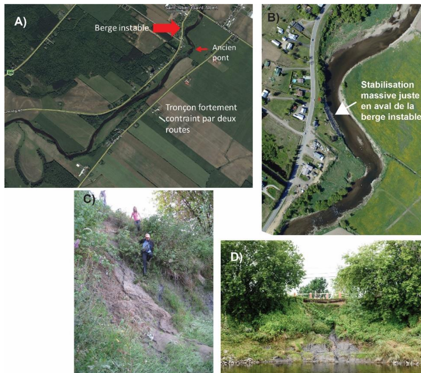
Figure 22. Site de St-Albert montrant A) les fortes contraintes engendrées par la présence de routes de part et d'autre de la rivière Nicolet, avec aussi un pont en amont et un ancien pont à l'aval de la zone d'étude; B) une stabilisation immédiate en aval de la zone instable; C) et D) la berge instable, avec à sa base de l'argile.
