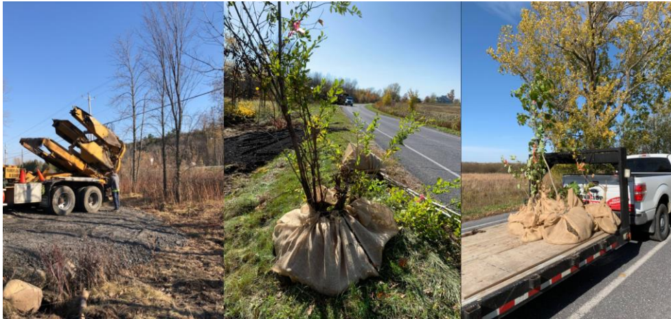
Figure 32. Construction du remblai dans la zone 8 et récolte des gaules arborescents
