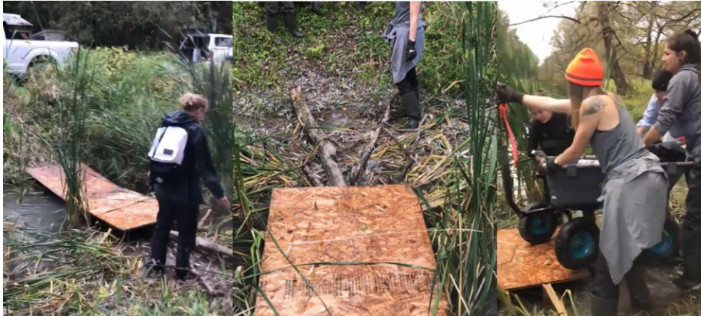
Figure 19. Pont temporaire créé pour traverser le ruisseau Louis-Rochelleau L'endroit pour effectuer la traversée avec le matériel fut choisi en fonction de la profondeur et de la largeur du ruisseau, mais également en fonction de la densité de végétation. Malgré qu'il fût occasionnellement inmanquable d'écraser quelques quenouilles dans les ruisseaux, nous avons choisi un lieu visant à limiter au maximum notre impact considérant toutes les contraintes.
