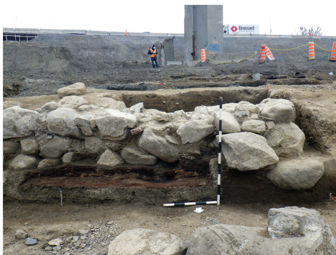
Photo 9.6 - Sous-opération 26V – Jonction des fondations ST-134 et ST-135 et jonction du bassin ST-168 et de la canalisation en bois ST-143 – Vue vers le sud (BiFj-118-17-N4-498)
