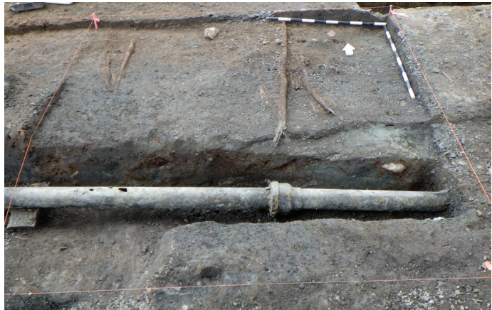
Photo 8.11 - Sous-opération 27C – Dépôt formant la base de la 3 e chaussée et conduite ST-120/ST-156. La présence de pièces de bois disposées perpendiculairement à l'axe du chemin est visible dans le dépôt – Vue vers le nord (BiFj-118-17-N2-605)
