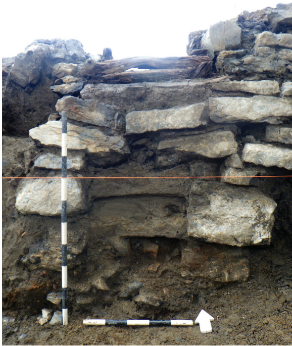
Photo 8.24 - Sous-opération 25F — Mur de soutènement sud du chemin Upper Lachine ST-113, parement sud. Détails de l'ouverture des canalisations en pierre ST-149 et en bois ST-161 — Vue vers le nord (BiFj-118-17-N2-693)
