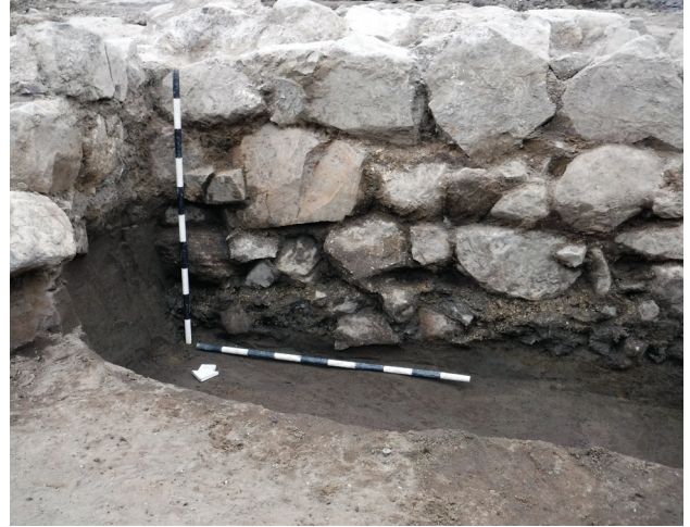
Photo 9.26 - Sous-opération 26U – Jonction des fondations ST-130 et ST-133, parements intérieurs. La profondeur d’enfouissement fort différente de ces deux ouvrages est visible sur le cliché – Vue vers le sud-est (BiFj-118-17-N3-300)
