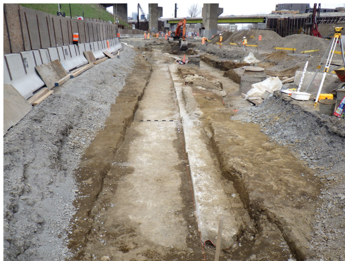
Photo 5.1 - Sous-opération 25E, extrémité ouest – Infrastructure actuelle de la rue Saint-Jacques (concassé de pierre calcaire), massifs de conduits bétonnés et sol naturel stérile dérasé – Vue vers l'est (BiFj-118-17-N4-144)
