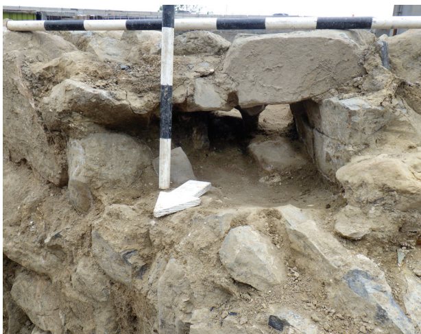
Photo 9.28 - Sous-opération 26Y – Ouverture aménagée dans la fondation ST-130 pour faire passer la canalisation ST-144 parement intérieur – Vue vers le sud-est (BiFj-118-17-N4-638)
