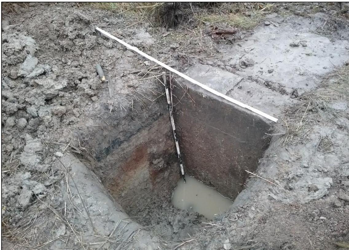
**Photo 11 : Ancrage sur la structure de ciment. Fondation de 95 cm de profondeur. Vers le nord-ouest (photo # 1572291488933).**
