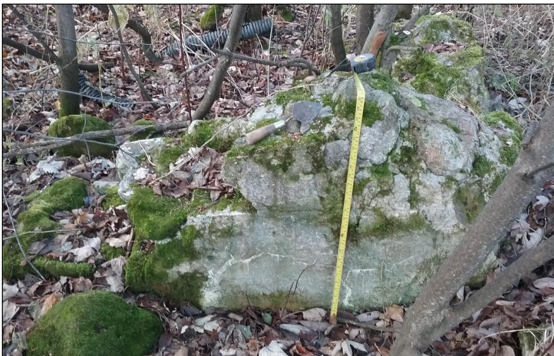
**Photo 8 : Coin nord-est en plan rapproché, démontre bien le type de muret fait de pierres et de béton vers l'ouest (# de photo 1572876065850).**
