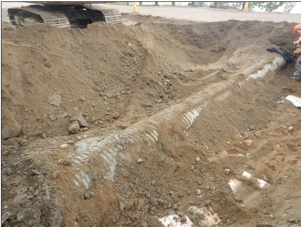
**Photo 13 : Ancienne conduite pluviale (ponceau centrale, partie sud) montrant d'épais remblais sous la route, lors de la réfection du ponceau. (vers le nord-ouest; DSCN1206)**
