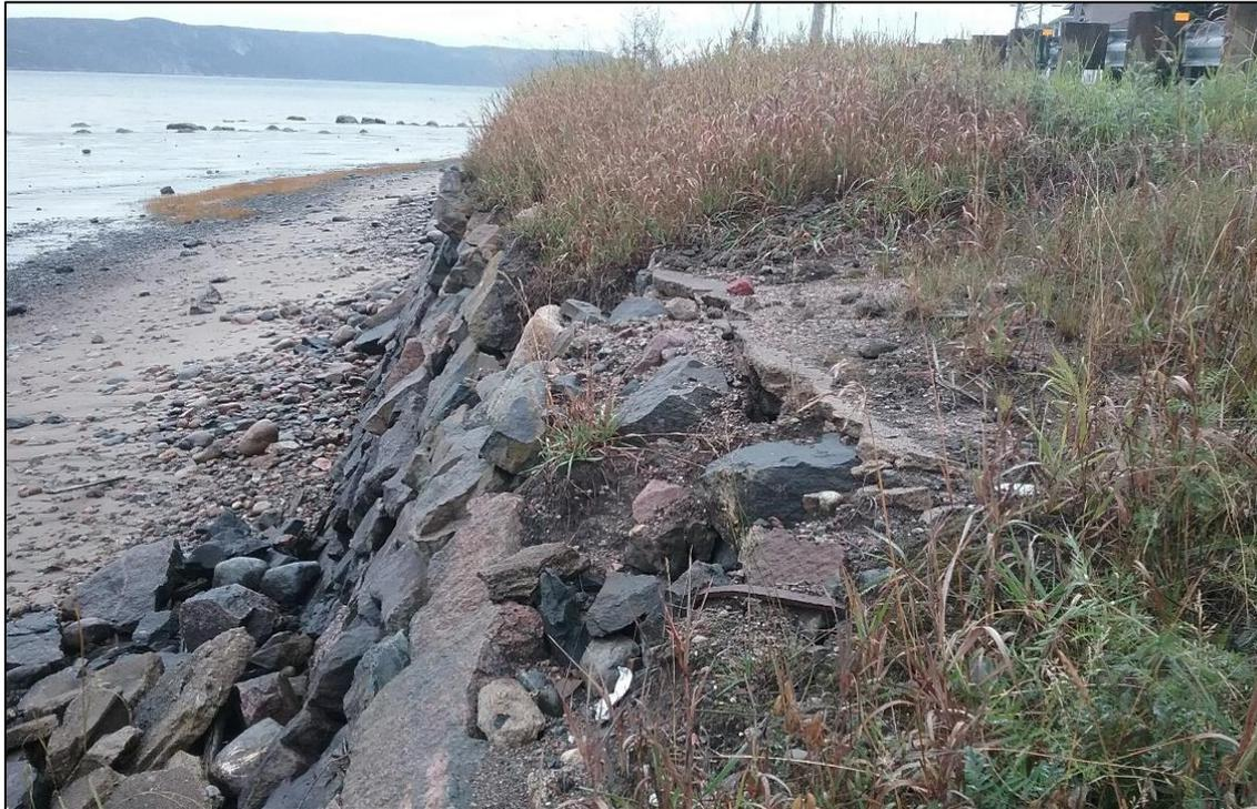
**Photo 10 : Muret de pierre à l'extrême ouest de l'emprise du MTQ pour protéger les berges de l'érosion. (vers l'est ; # de photo 1569504609089)**
