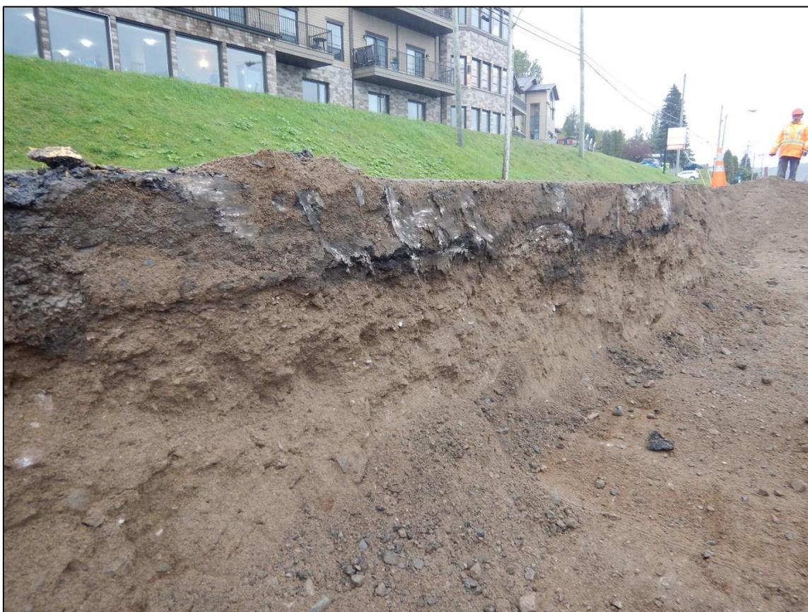
**Photo 12 : Tranché démontrant d'importants niveaux de remblai avant la route sur le ponceau central, partie nord . (vers le sud-ouest ; # de photo DSCN1159)**
