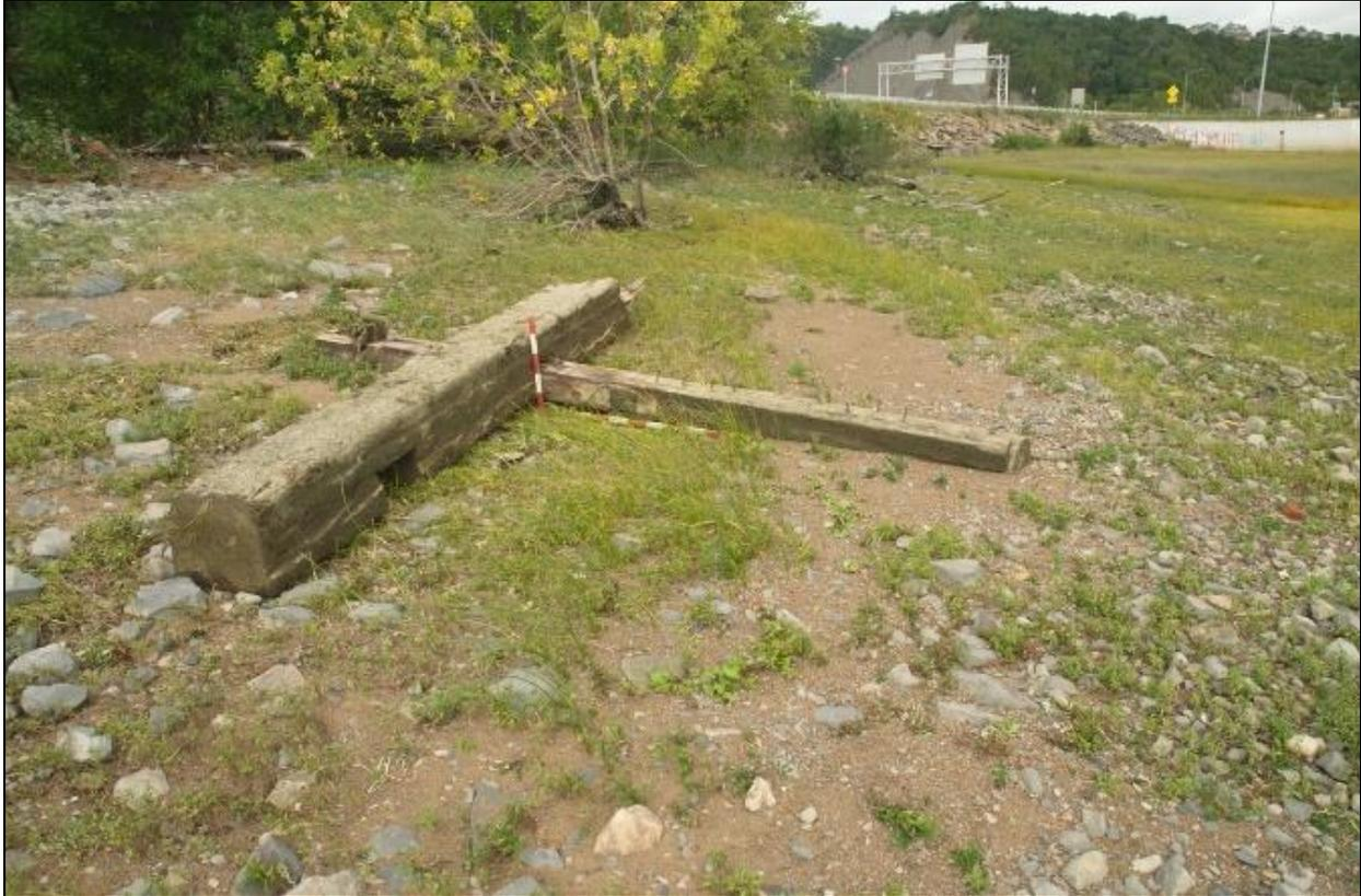
**Photo 13.** Longrine et poutre associées à l'extrémité sud de la structure Q1-ST-2 après son arrachement par les grandes marées, vers le nord-nord-est (CfEs-38-2018-164)
