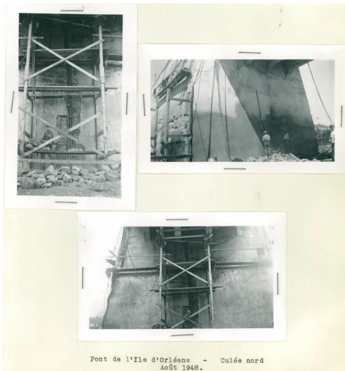
**Figure 72.** Photos montrant les échafaudages mis en place afin de permettre les travaux de réfection de la culée nord du pont de l'île d'Orléans à la fin des années 1940 (MTQ/Dossier des Structures)
