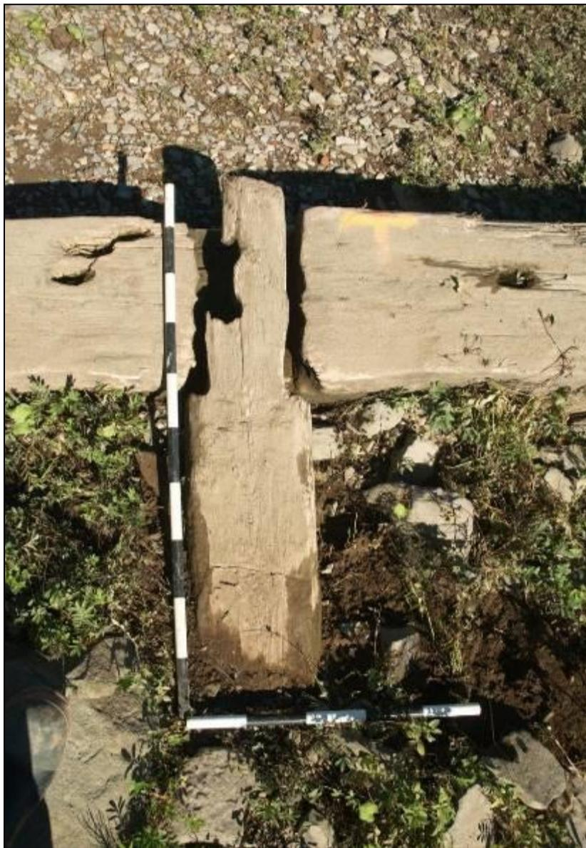
**Photo 7.** Assemblage en queue d'aronde dite « à plat » avec trou de cheville ou de clou, en plongée (CfEs-38-2018-256)
