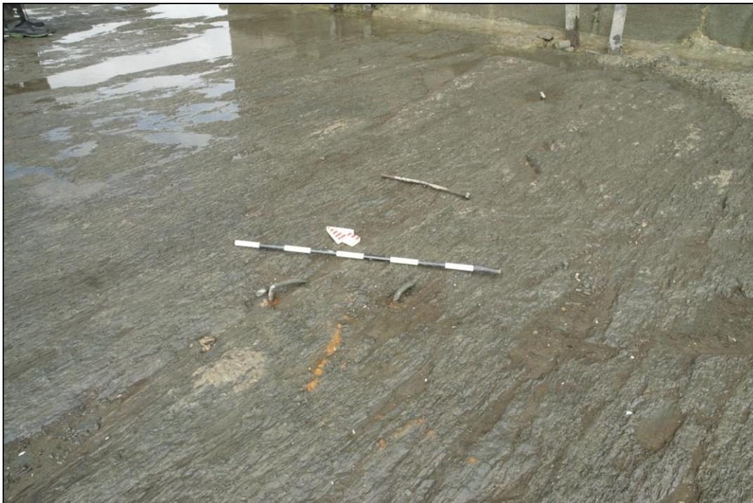
**Photo 91.** Tiges de métal repliées et insérées dans le roc, vers le nord-nord-est (MTQ-PONTÎO-2018-168)
