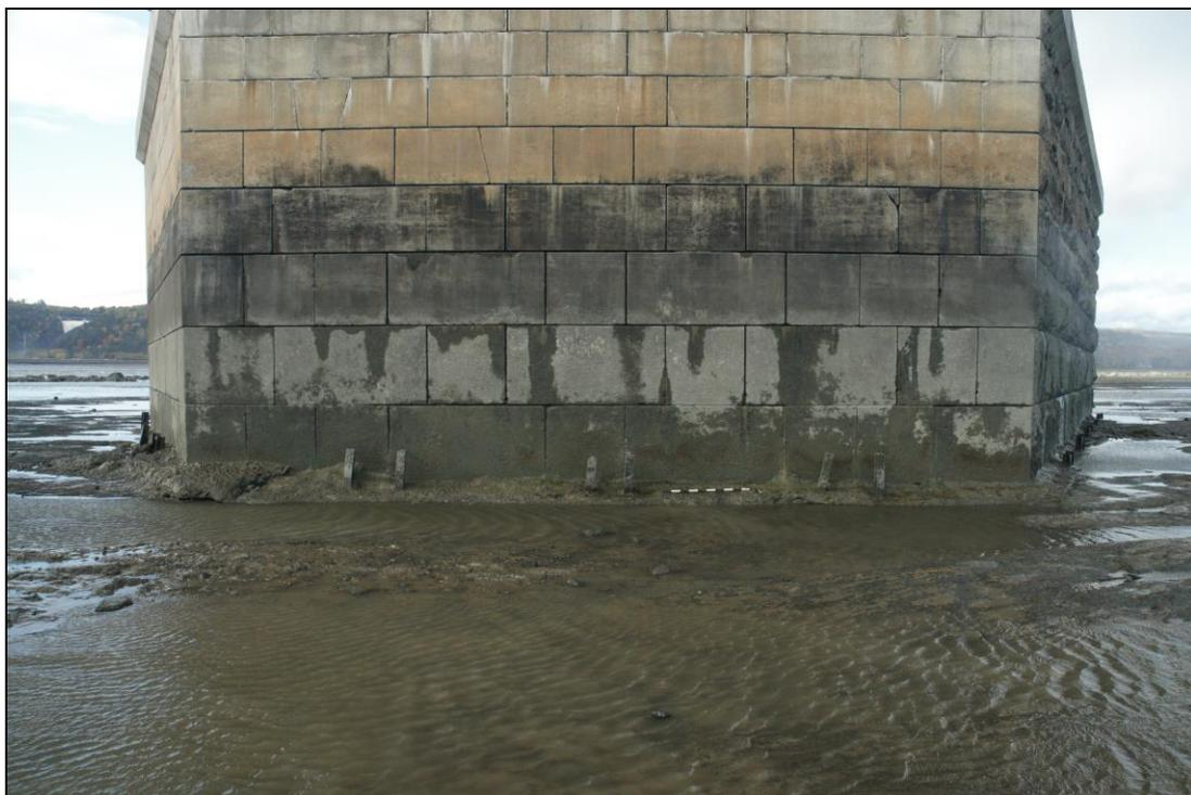
**Photo 87.** Vue des rails de chemin fer posés à la verticale contre le parement du pilier sud du pont, vers le nord (MTQ-PONTÎO-2018-127)
