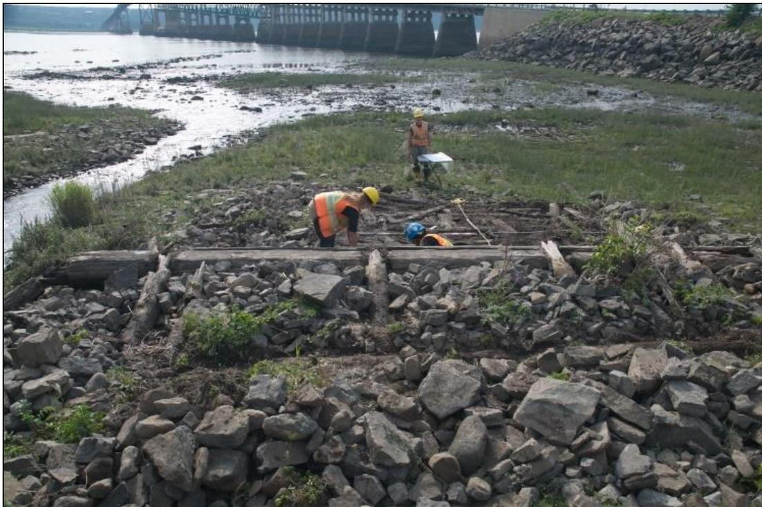
**Photo 34.** Vue des pièces de bois servant de tirants pour la rétention du mur sud de la structure Q2-ST-2, vers le sud-sud-est (CfEs-38-2018-005)
