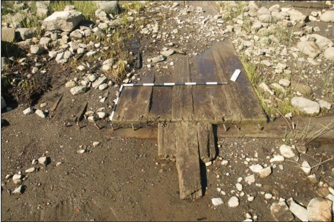
**Photo 11.** Détail de la fixation des madriers sur les poutres de la structure Q1-ST-2, vers le nord (CfEs-38-2018-242)
