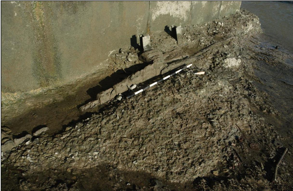
**Photo 88.** Détail des anciens rails de chemin de fer posés à la verticale et étançonement fait de planches le long de la paroi nord-ouest du pilier d’ancrage sud des haubans, vers le sud-est (MTQ-PONTÎO-2018-126)
