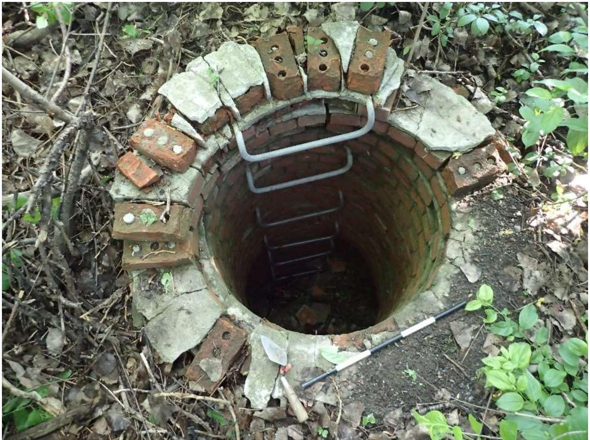
Figure 109 : Projet 154-15-1176, site BiFl-15, photographie du trou d'homme en briques 3H100 trouvé dans la portion ouest de la zone 8. Vue vers l'est. BiFl-15-19-N3 (43).
