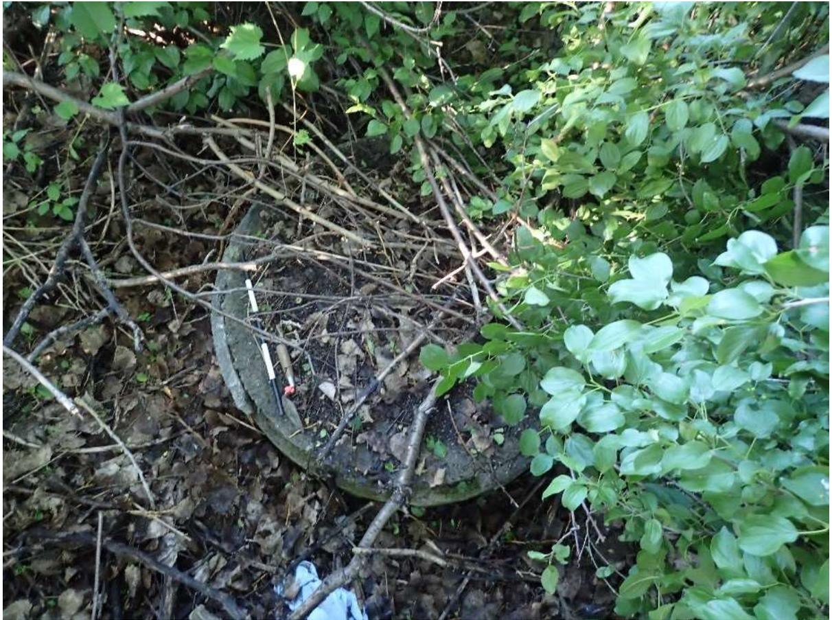
Figure 110 : Projet 154-15-1176, site BiFl-15, photographie d'un couvercle de béton scellant un ancien trou d'homme (4H100). Vue vers le sud. BiFl-15-19-N3-48.
