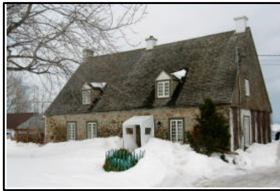
Figure 50 : La maison ancestrale des Ferland située au 306 rue du Galendart à Saint-Pierre (photo : Richard Lapointe).
