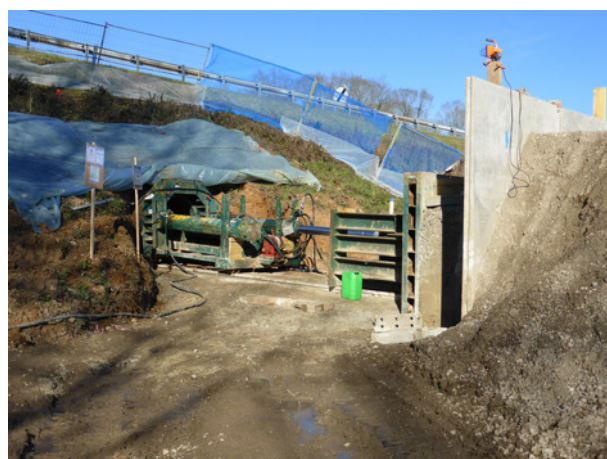
Illustration 10 : Vue sur le dispositif de poussée
