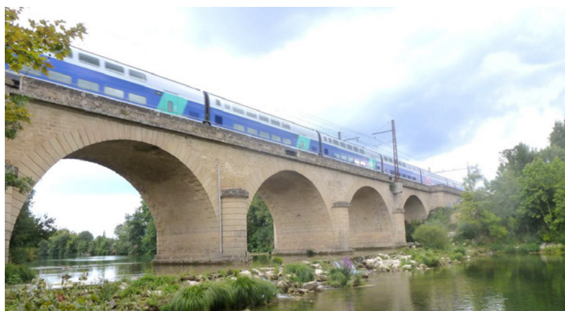
Illustration 6 : Pont ferroviaire de Gallargues sur le Vidourle avant travaux – Source : SNCF Réseau.
