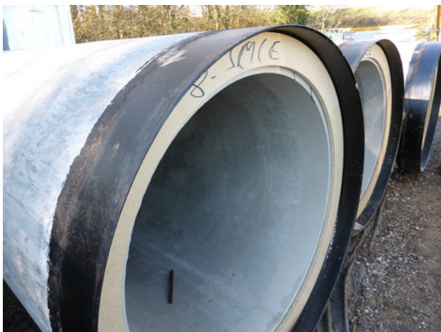
Illustration 15 : Vues sur les anneaux métalliques
