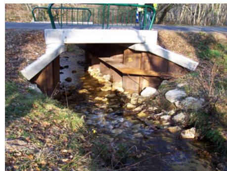
Illustration 1 : Pont de Luas, amont après travaux – Crédit : Cerema – Marc Gigueux.
