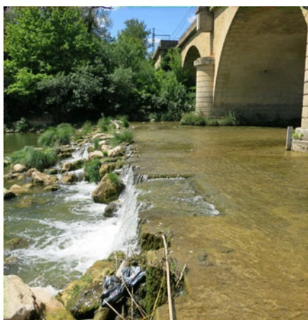
Illustration 5 : Vue sur le seuil – Source : SNCF Réseau.
