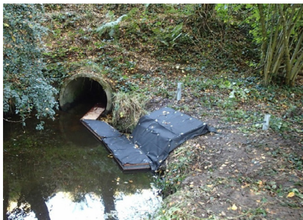
Illustration 14 : Vue aval de l'ouvrage – Source Grege.
