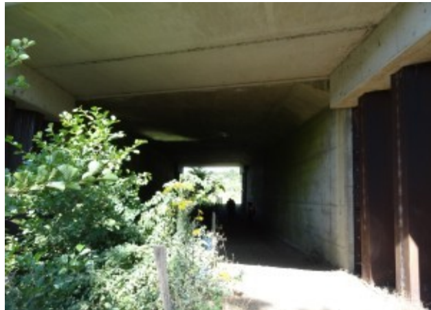
Illustration 8 : Passage mixte après élargissement Source : Sanef/SAPN.
