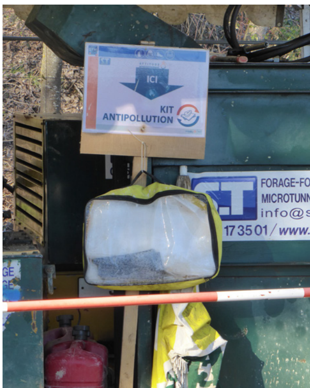
Illustration 17 : Gestion environnementale du chantier.
