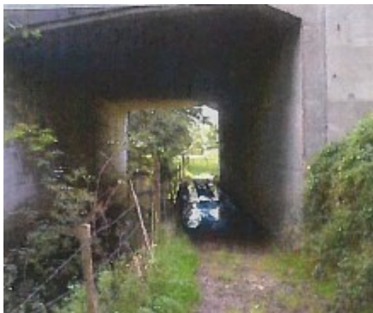
Illustration 9 : Passage mixte avant les travaux Source : Sanef/SAPN.
