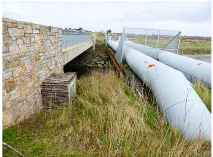
Illustration 7 : Vue sur les canalisations positionnées devant l'ouvrage. Crédit : Cerema – J.-F. Bretaud
