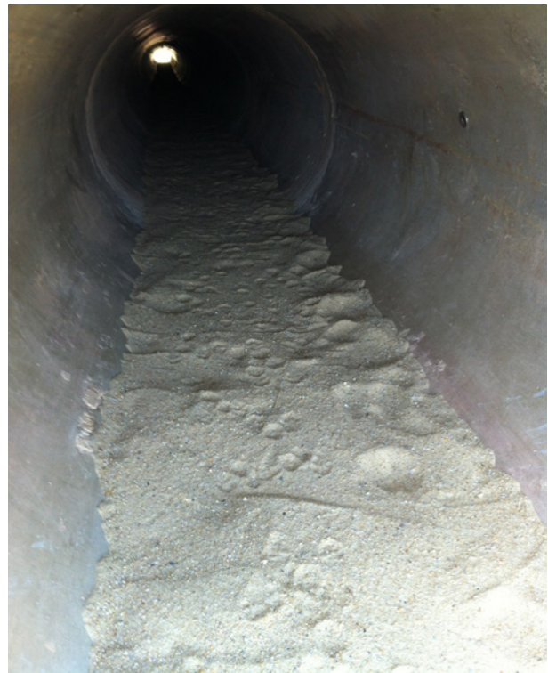
Illustration 20 : Mise en place d'un substrat naturel réalisé par Cofiroute.
