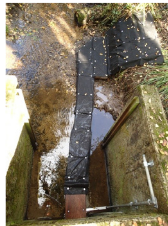
Illustration 15 : Vue sur l'amont de l'ouvrage – Source : Grege.
