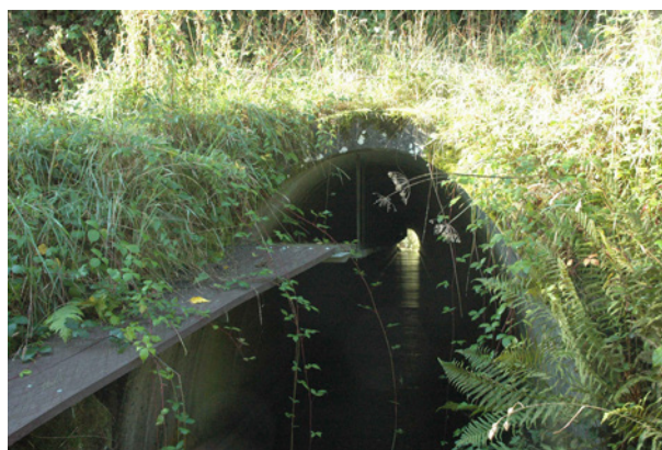
Illustration 11 : Vue sur l'aval de l'ouvrage Crédit : Cerema – J.-F. Bretaud.
