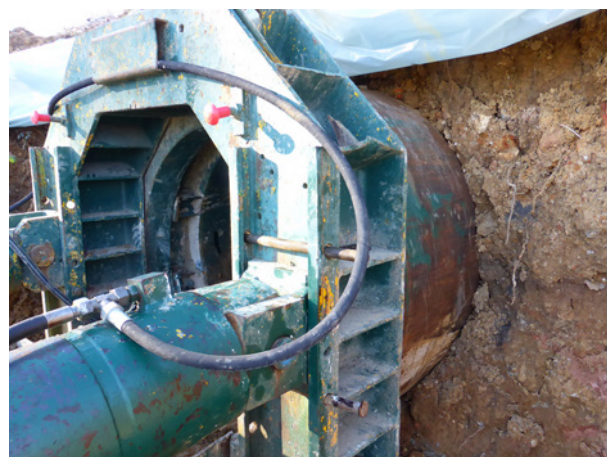
Illustration 12 : Vue sur l'élément de découpe du remblai
