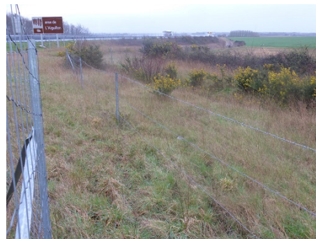
Illustration 1 : Déplacement de clôture sur A83 Crédit : Cerema – Christophe Pineau.
