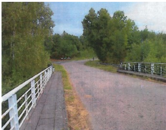
Illustration 6 : Passage supérieur avant réalisation Source : Sanef/SAPN.
