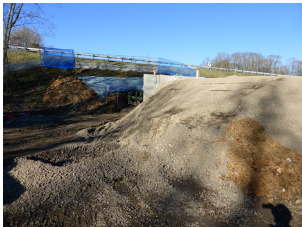
Illustration 11 : Vue sur le contrepoids de poussée
