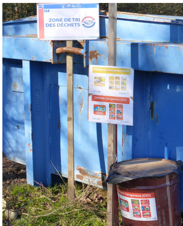
Illustration 18 : Gestion environnementale du chantier.
