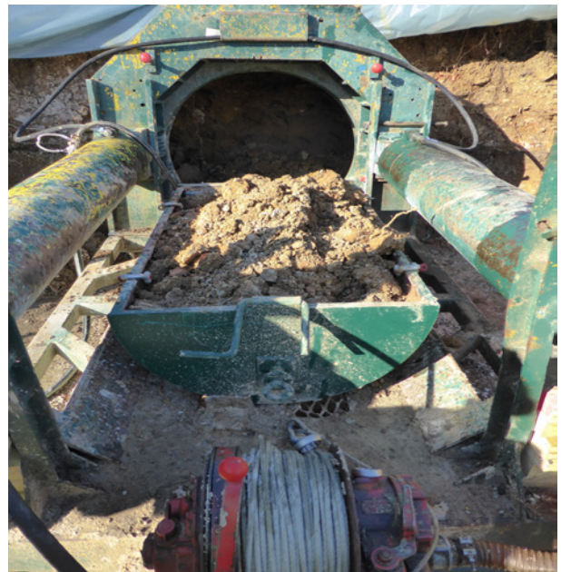
Illustration 14 : Vue sur le chariot d'évacuation des déblais
