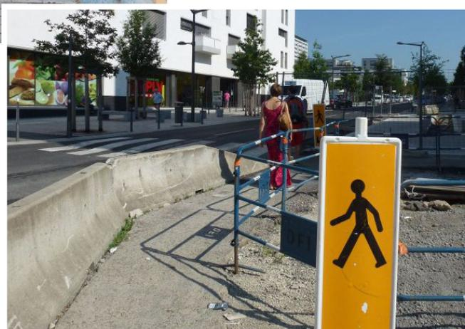
Exemple de barrières dont le barreau horizontal inférieur est détectable.
