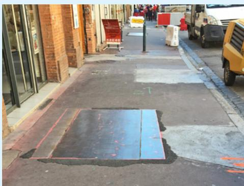
L'encastrement des plaques provisoires recouvrant les tranchées permet d'éviter les ressauts accidentogènes pour tous et de maintenir l'accès au bâtiment riverain. (Source : Toulouse métropole)
