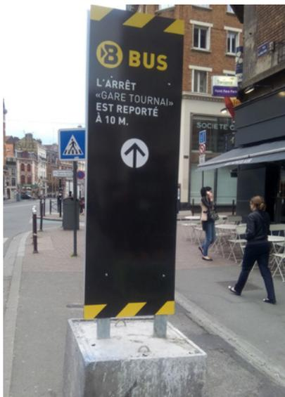
Exemple de panneau informant du déplacement d'un arrêt de bus. Il est positionné en dehors du cheminement principal et laisse une largeur de passage confortable. Son socle est détectable et il ne comporte pas d'éléments en porte-à-faux.
