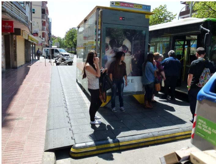
Autre exemple de quai de bus modulaire, cette fois à Barcelone. Le raccordement au trottoir est facile et se fait sur une grande longueur, ce qui permet d'éviter les vides et les ruptures de niveau. (Source : Cerema)
