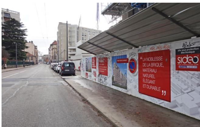
Exemple de la suppression d'une bande de stationnement au profit de la création d'un trottoir provisoire en béton, avec casquette protectrice. (Source : Cerema)
