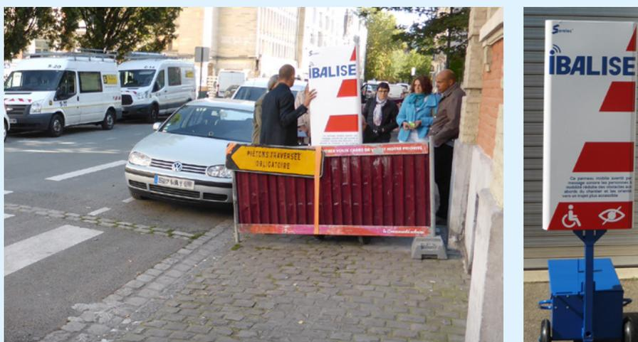
Le dispositif « iBalise », développé par la société Serelec, implanté au niveau d'un passage piétons pour signaler la présence du chantier et le comportement à adopter. (Source Cerema)
