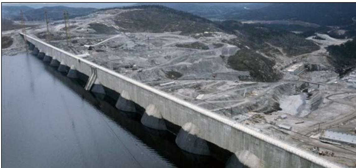
**Figure 10: Mise en eau du réservoir en cours de réalisation (post 1968). Les aménagements associés à la construction du barrage sont encore visibles sur le côté aval du barrage. (Source : BAnQ, 06M\_P697S1SS1SSS08D001\_31)**
