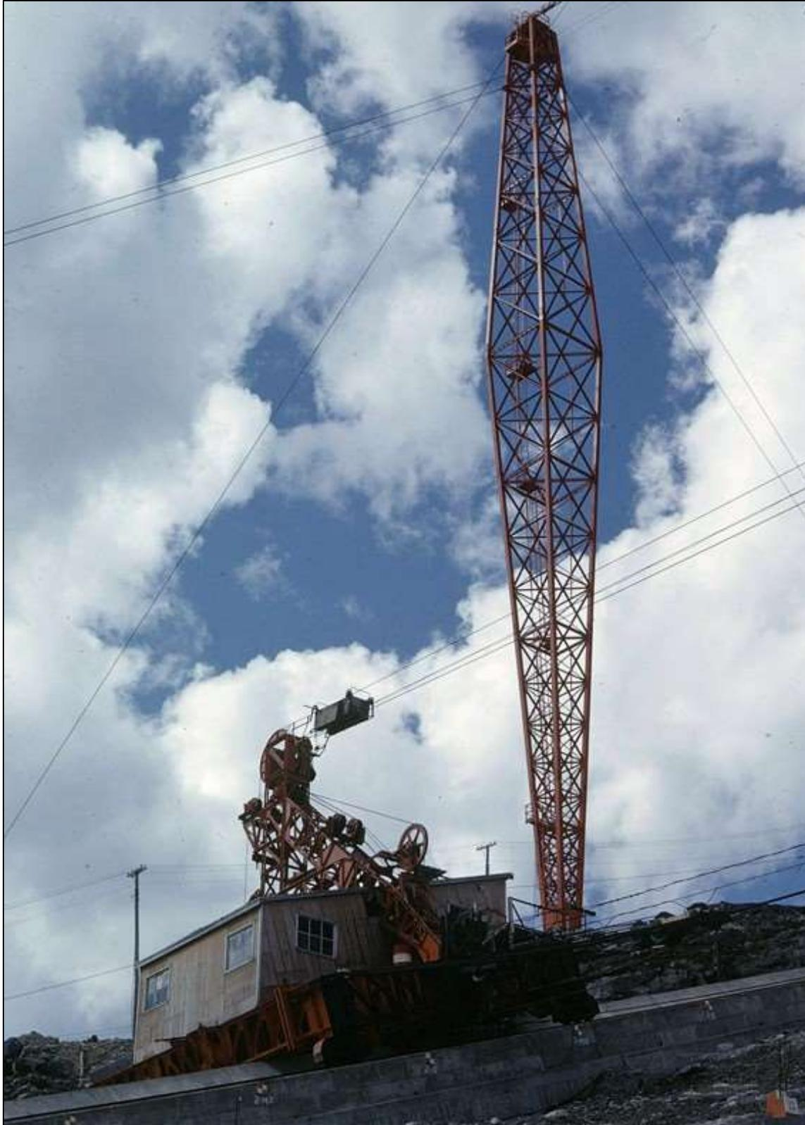
**Figure 39: Détail de la tour d'éclairage trapézoïdale sur la rive droite du barrage. La tour sur la rive gauche était identique. (Source : BAnQ, 06M\_P697S1SS1SSS08D001\_049)**
