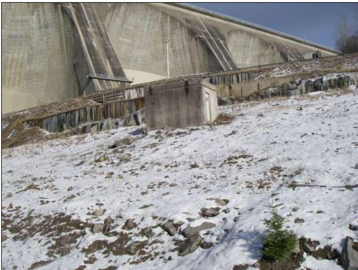
Figure 42: Édicule de la pendule située au pied du barrage. (Source : Ministère des Transports)
