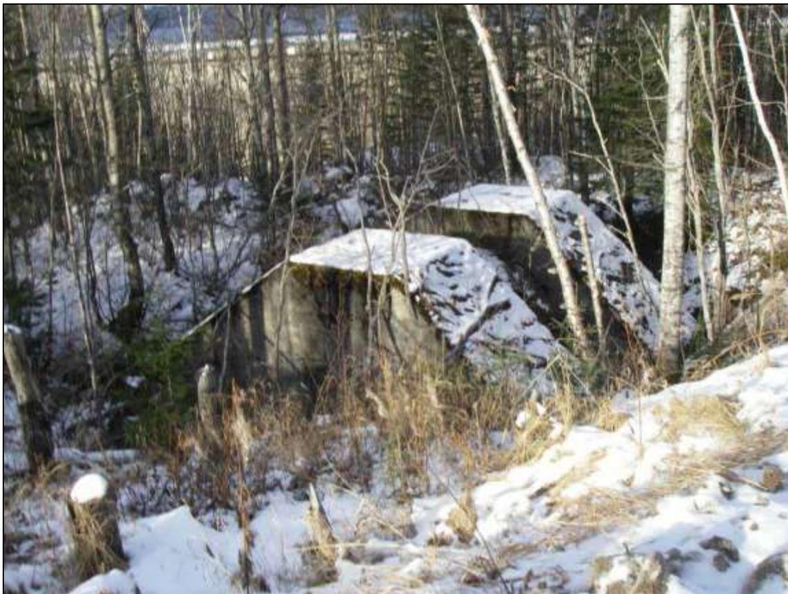
**Figure 31:** Base d'encrage de câble d'aubage latéral repérée dans l'aire d'étude. (Source : Ministère des Transports)
