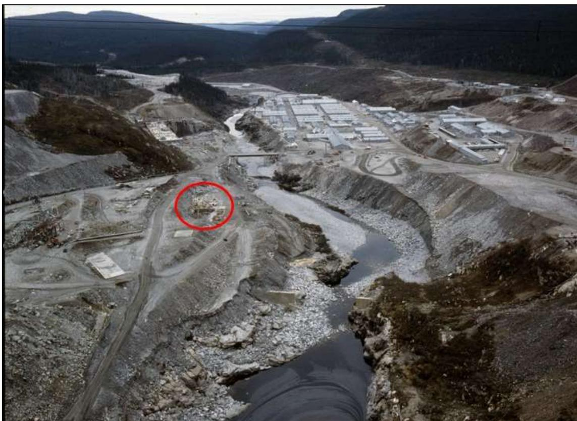
**Figure 27: Vue du site indiquant l’emplacement de la bétonnière temporaire [1968]. La centrale, visible à l’arrière-plan, est en cours de construction.** (Source : BAnQ, 06M\_P697S1SS1SSS08D001\_028)
