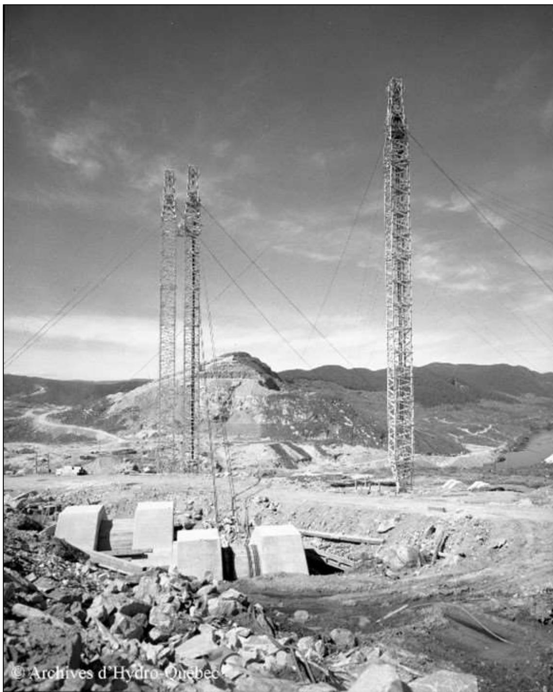
**Figure 28: Tours fixes des blondins sur la rive gauche du barrage. Deux bases d'encrage de câbles d'aubage latéraux sont visibles à l'avant-plan. (Source : Archives d'Hydro-Québec, H02\_701804\_#135190-6\_Manic-5\_Tours.)**
