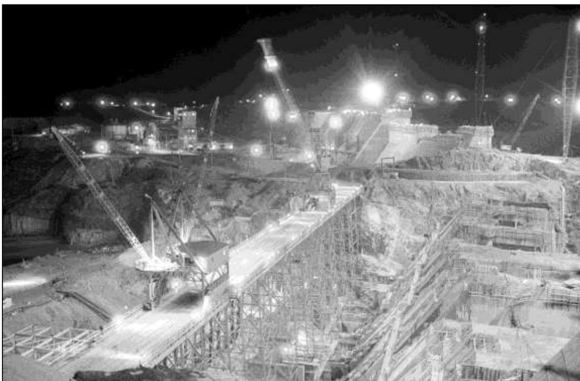
**Figure 38: Éclairage du site du barrage en cours de travaux. Les tours trapézoïdales supportant les câbles auxquels étaient fixées les lampes au mercure sont visibles à droite.** (Source : BAnQ, 06M\_P697S1SS1SSS08D001\_021.)
