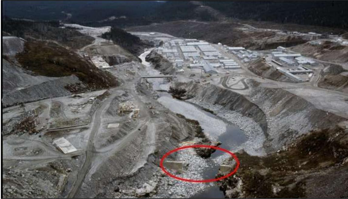
Figure 36: Murets d'approche du batardeau aval. (Source : BAnQ, 06M\_P697S1SS1SSS08D001\_028)
