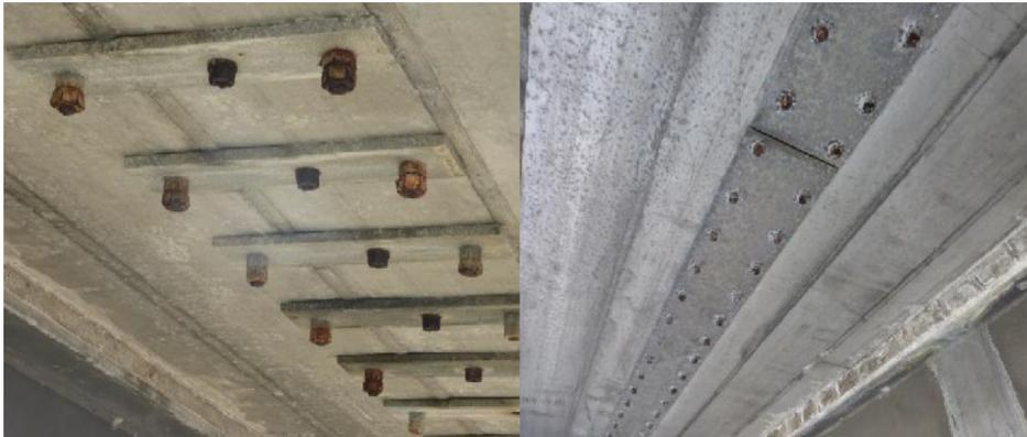
**Figure 2-5** Corrosion des boulons du pont de l'US Route 58, après 19 ans de service
