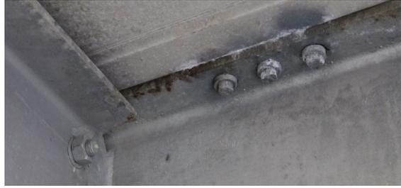
**Figure 2-9 Corrosion galvanique aux interfaces acier-aluminium, juillet 2018**
