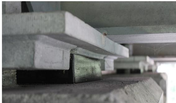
**Figure 2-10 Cisaillement des appuis, juillet 2018**
