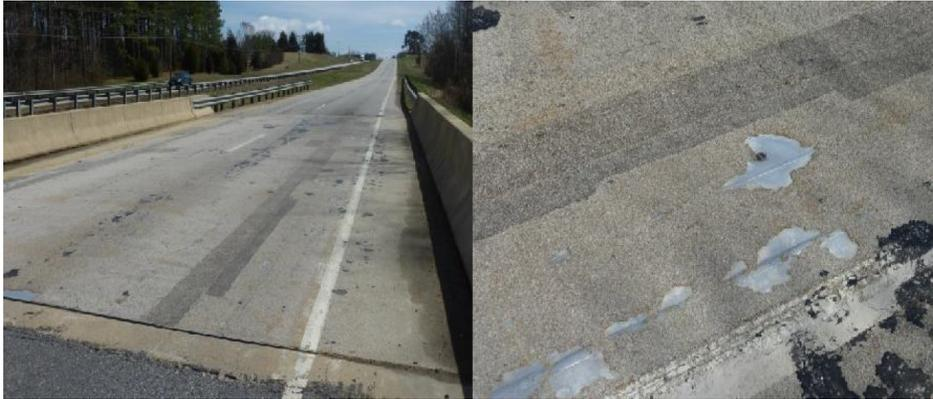
**Figure 2-4** Usure de la surface de roulement du pont de l'US Route 58, après 19 ans de service
