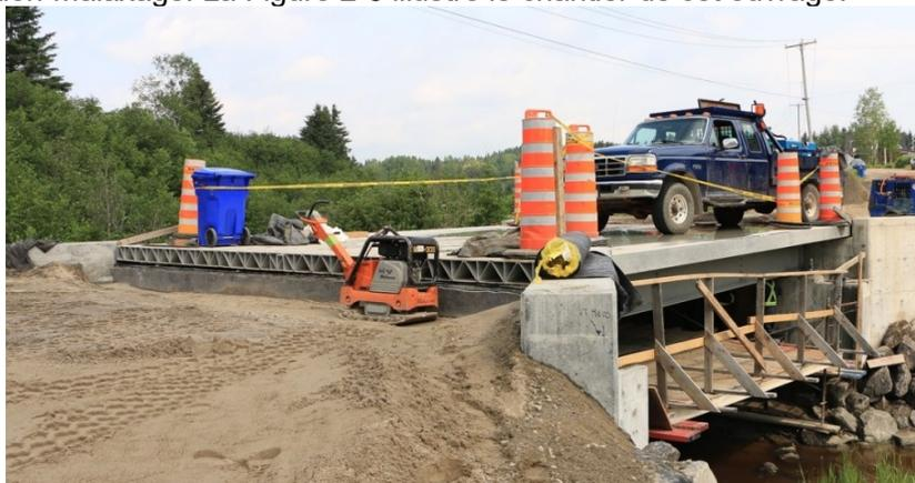
**Figure 2-6** Chantier de l'installation du platelage du pont de Saint-Ambroise
