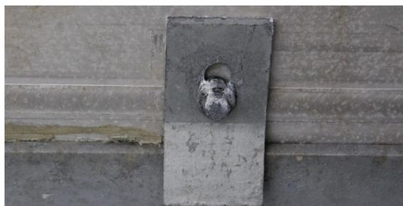
**Figure 2-8** Corrosion d'un boulon fixant une bride en acier au platelage en aluminium, juillet 2018
