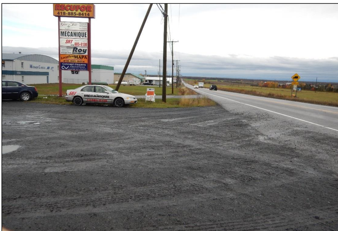
Photo 6 : Projet 154-01-0315, inspection visuelle d'une façade de commerce, entrée principale du 50 route Bégine, direction nord-ouest
