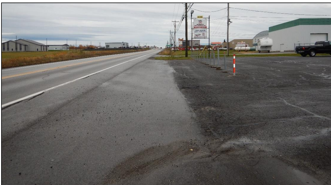
Photo 8 : Projet 154-01-0315, inspection visuelle face à l'entrée du 436 rte Bégin, direction sud-est
