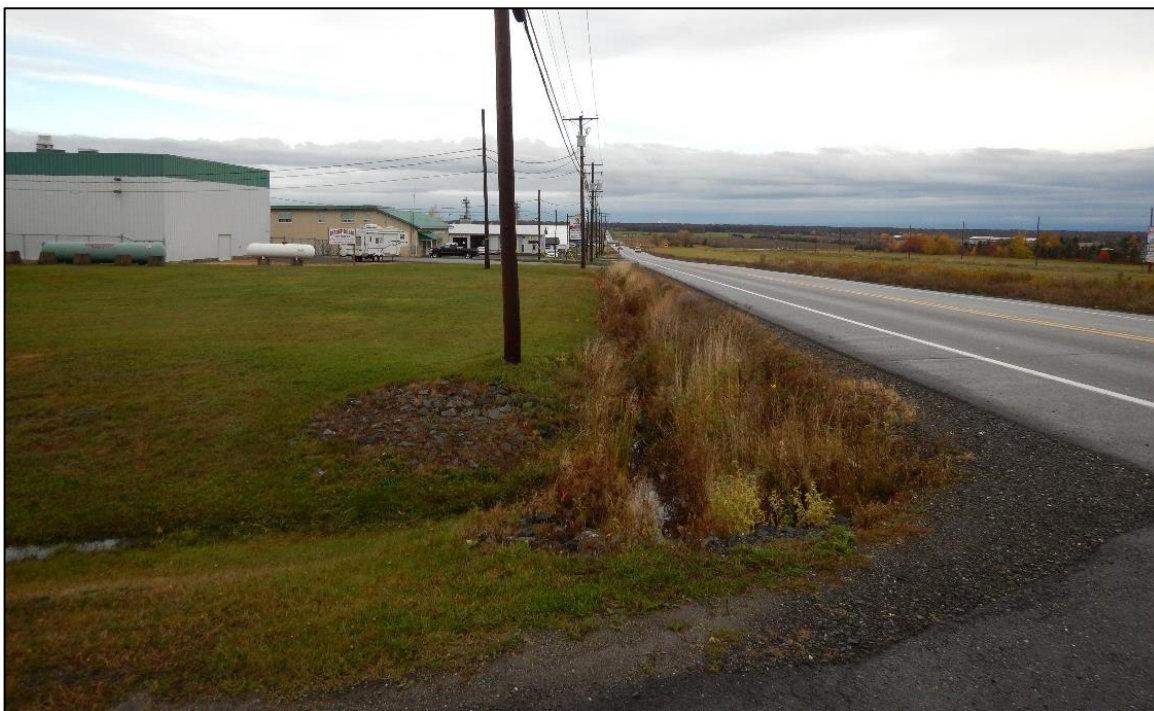
Photo 7 : Projet 154-01-0315, inspection visuelle du fossé et du terrain aménagé face au 450 rte Bégin, direction nord-ouest
