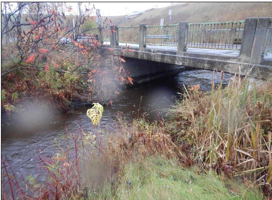
Photo 14 : Projet 154-99-0324, aperçu d'une portion du ruisseau Terrebonne situé à l'ouest de la route 171, direction nord-est.
