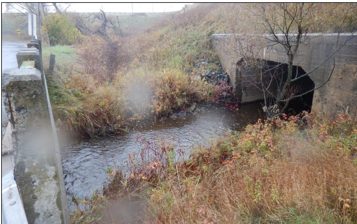
Photo 12 : Projet 154-99-0324, aperçu de la portion sud-est du ruisseau Terrebonne situé à l'ouest de la route 171, direction nord.
