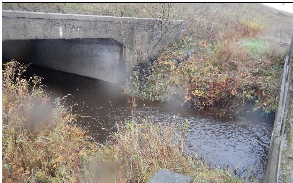
Photo 13 : Projet 154-99-0324, aperçu de la portion nord-est du ruisseau Terrebonne situé à l'ouest de la route 171, direction sud.
