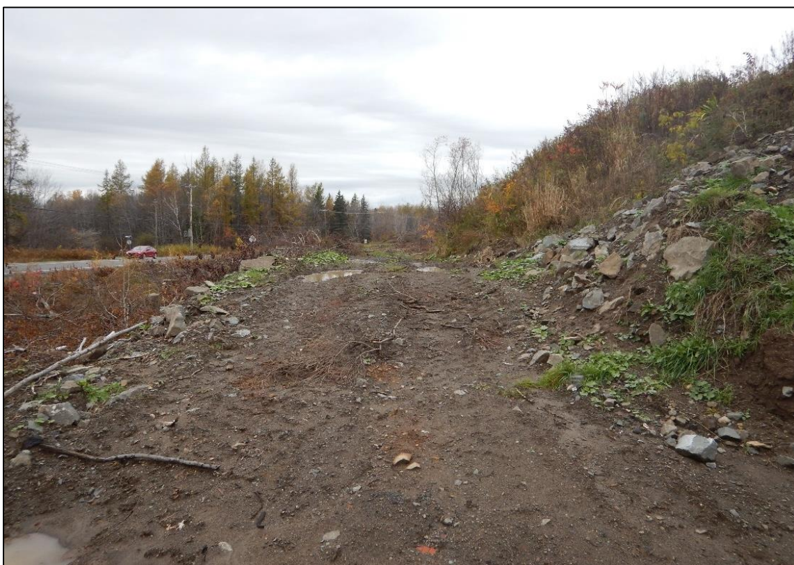
Photo 9 : Projet 154-99-0324, aperçu d'une portion de la zone P-6 démontrant des perturbations d'origine anthropique majeures, direction ouest.
