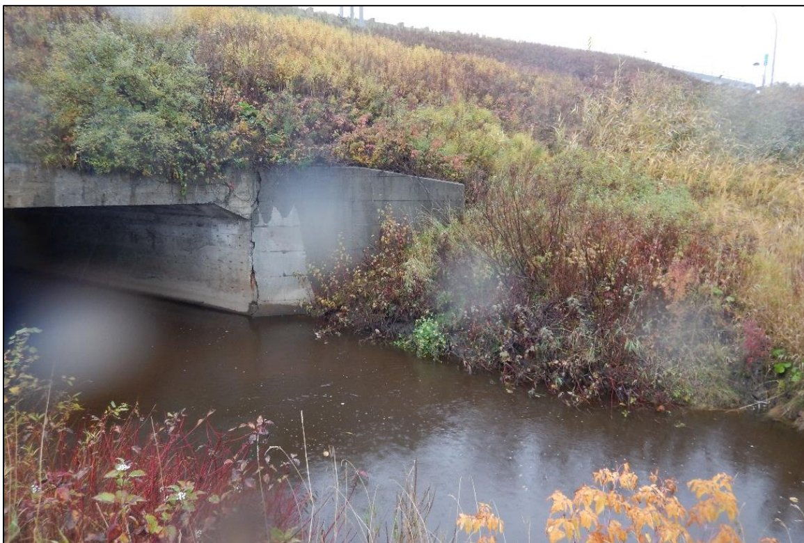
Photo 16 : Projet 154-99-0324, aperçu de la portion nord-est du ruisseau Terrebonne situé à l'est de la route 171, direction nord-ouest.
