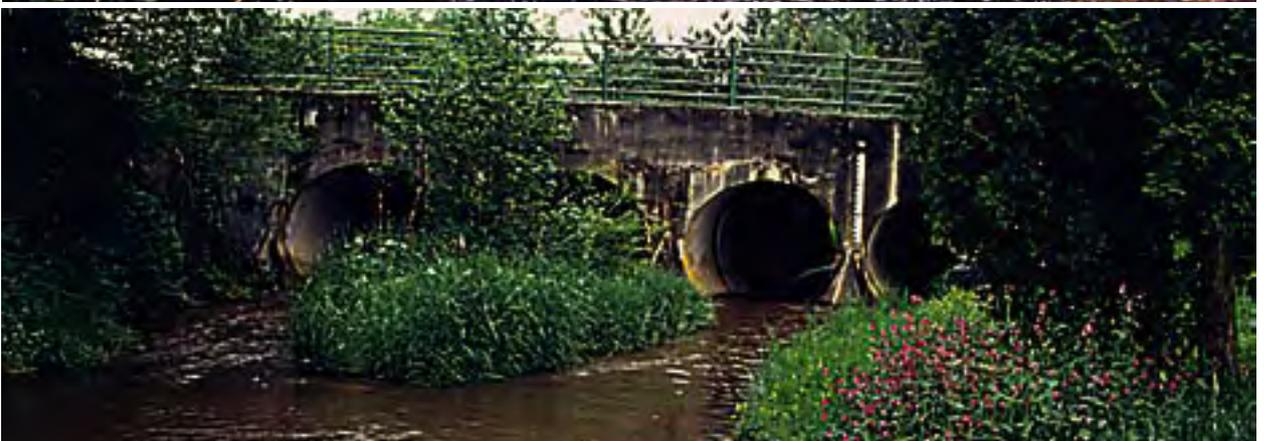
Ouvrage en lit mineur [source : Marc Gignoux - CETE de l'Est] - Chutes d'eau en aval, seuil en béton apparent, obstacle à l'écoulement (embâcles)
