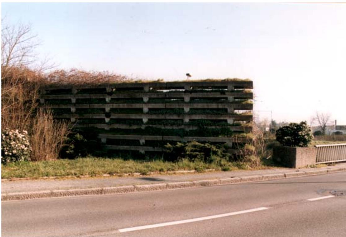
*Écran phonique construit à partir de modules béton empilables. Ce dispositif n'est satisfaisant que si un contrôle permanent du tassement de la terre est effectué. Ce n'est pas toujours le cas vu leur implantation et la difficulté de leur accès*
