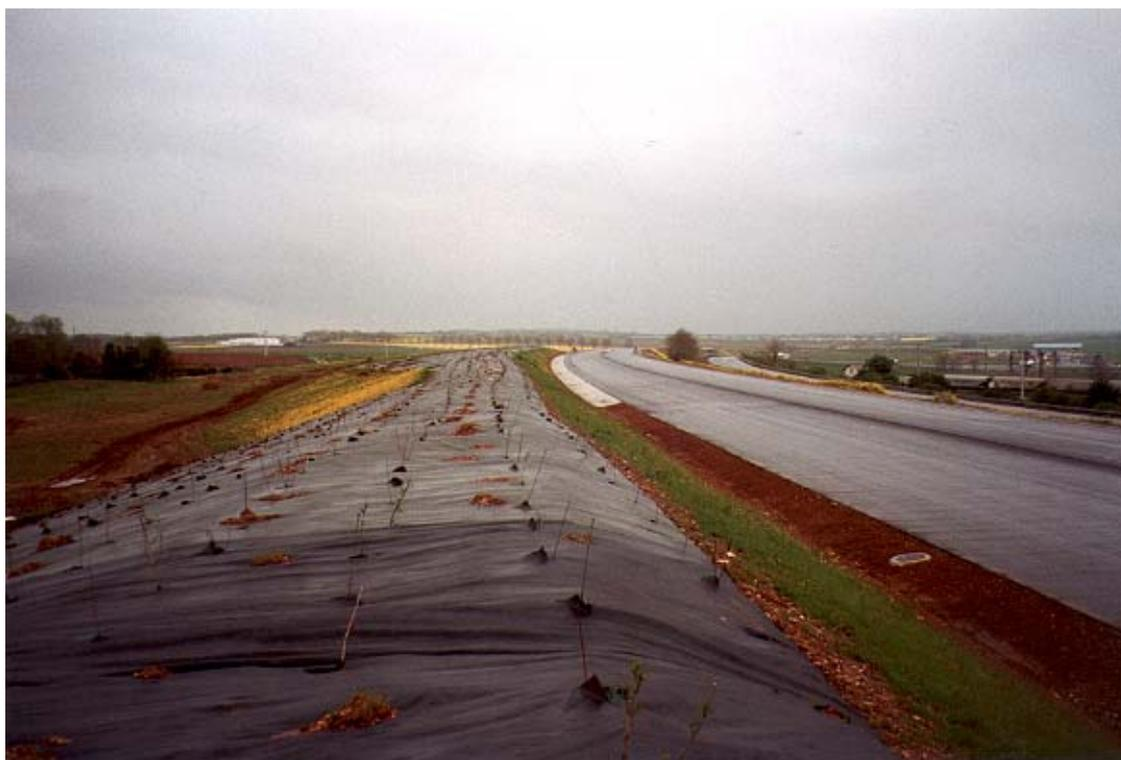
*Merlon acoustique végétalisé avant la mise en service de l'A 83. La pente adoucie côté riverain améliore l'insertion des terrassements*
