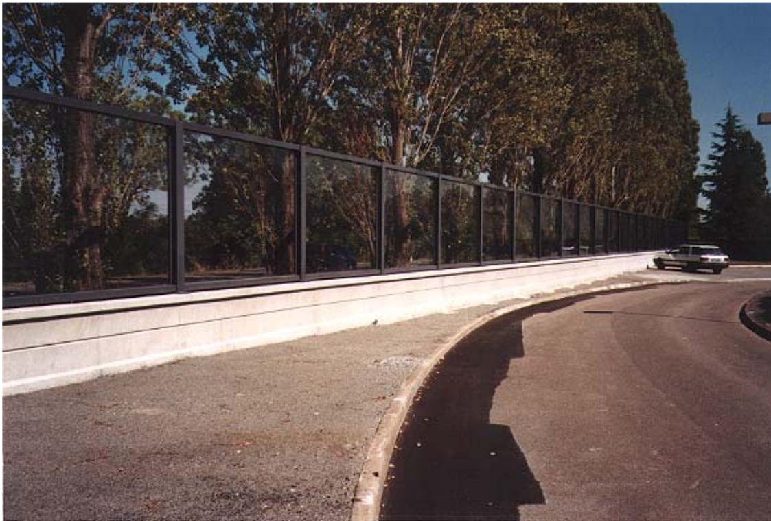
*Un écran entre une voie très fréquentée et un lotissement. La protection acoustique réduit le bruit émis, le maintien des peupliers bruisant au moindre vent supplante le niveau sonore de la voie, les vues sur les « arrières bocagers » sont toujours possibles du fait de la transparence : l'objectif paysager est atteint.*
