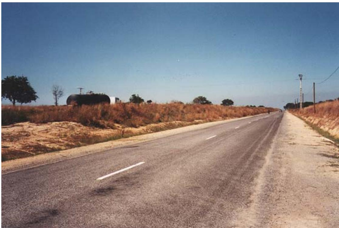
*Buttes de terre isolant visuellement l'infrastructure des voies nouvelles de désenclavement construites parallèlement dans le cadre d'une mise aux normes autoroutières*
