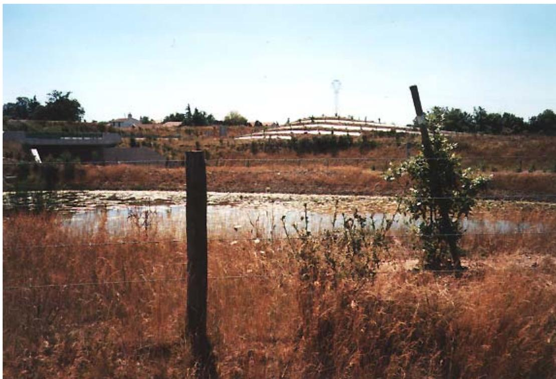
*Modelage de terre arable à l'intérieur des boucles d'un échangeur et végétalisation*
