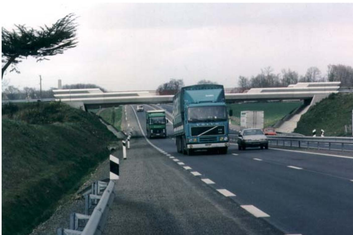
*Un abaissement du profil en long permet de minimiser l'impact des passages supérieurs, mais ce procédé engendre des surplus de matériaux qu'il faut disperser dans un rayon relativement proche pour éviter des surcoûts de déplacement*
