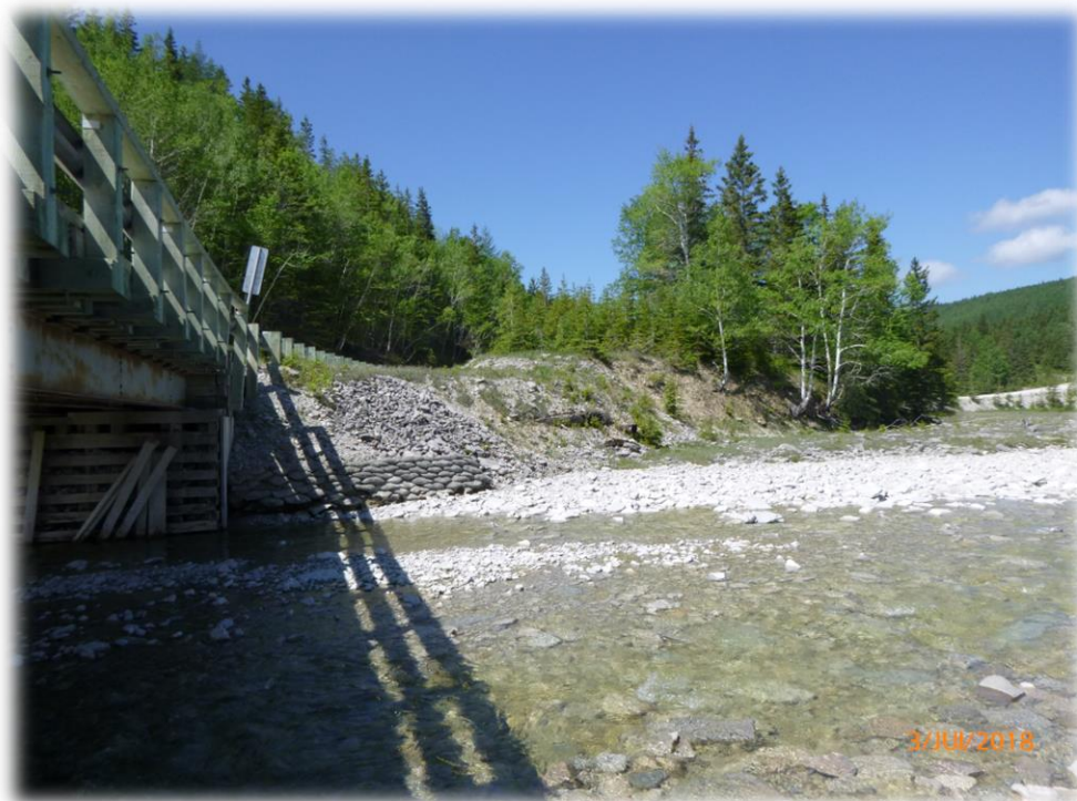
Figure 41 : Environnement de la zone 4, à l'approche nord-ouest du pont actuel de la rivière à la Patate Est, à l'emplacement de l'ancienne culée de pont en billes de bois et des sacs de sable de ciment. Projets 154-13-0032 et 154-13-0033 (Photo 154130033_180703_021).
