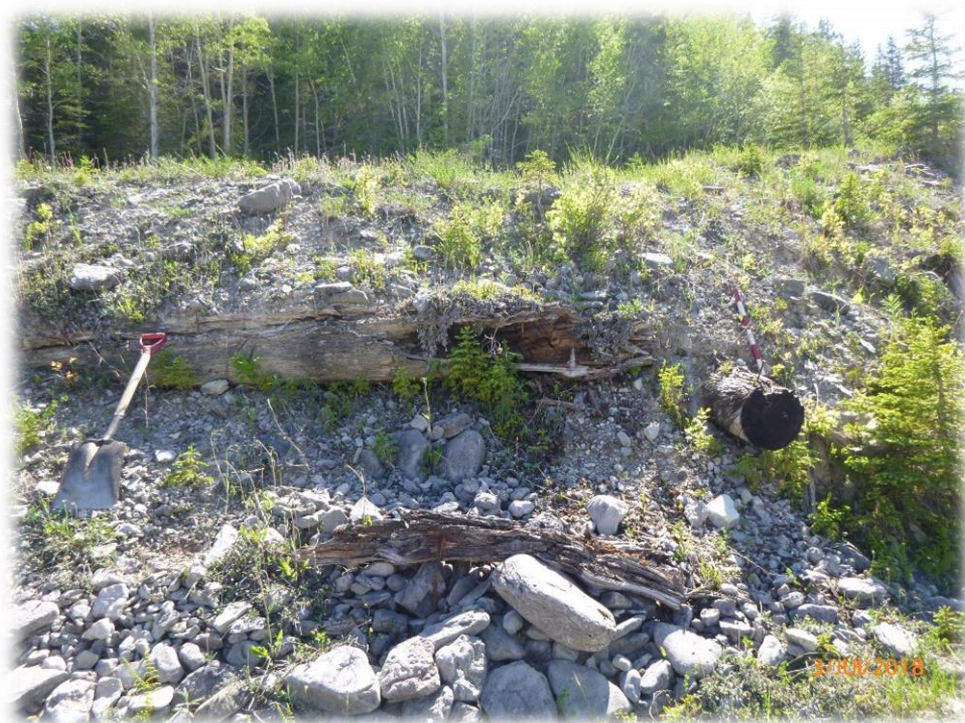
Figure 42 : Vue générale de l'ancienne culée de pont en billes de bois, à l'est de la zone 4, à l'approche ouest du pont de la rivière à la Patate Est. Projets 154-13-0032 et 154-13-0033 (Photo 154130033_180703_054).
