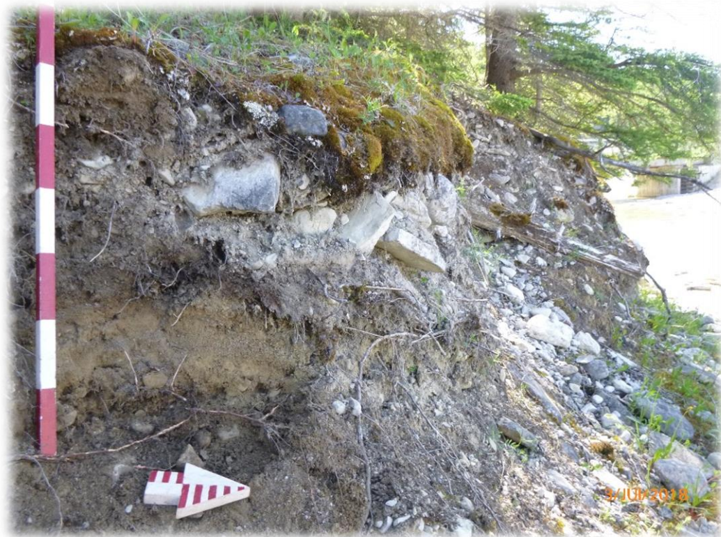
Figure 32 : Environnement et inspection des couches de sol dans la paroi du talus d'érosion au nord-ouest de la zone 4. Projets 154-13-0032 et 154-13-0033 (Photo 154130033_180703_053)
