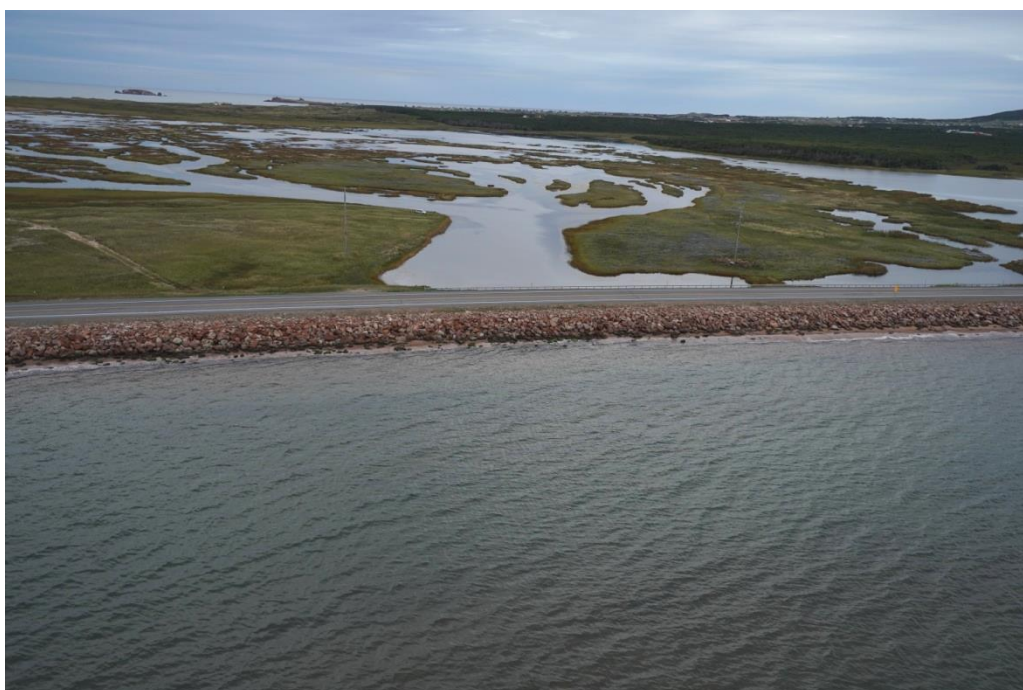
Figure 21. Côte à tombolo artificialisée par un enrochement (La Martinique, Îles-de-la-Madeleine)
