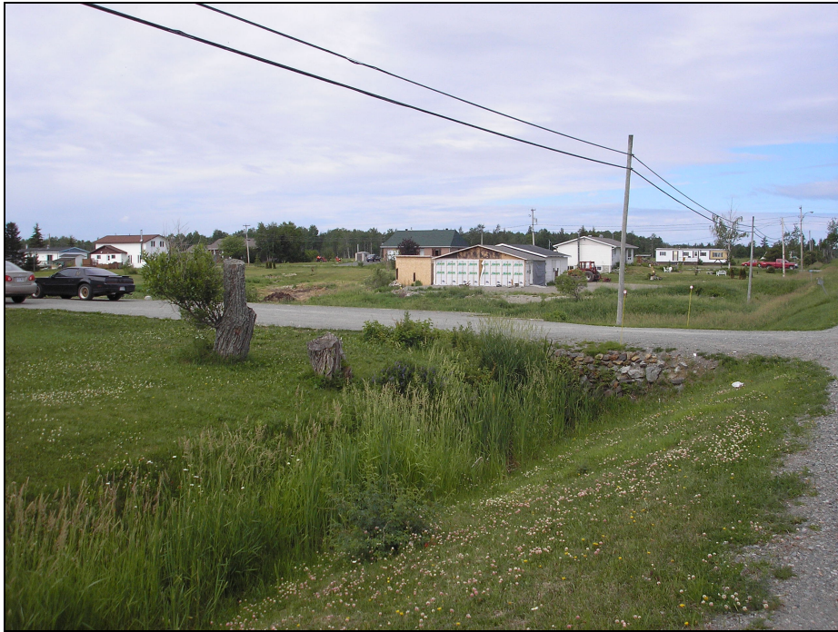
Photo 13 Projet 20-5800-0319, secteur sud-ouest (IV) de la route 397. Vue vers le sud-ouest.
