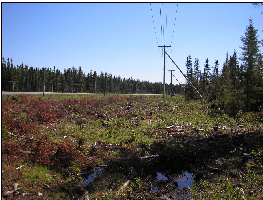
Photo 17 Projet 20-6871-9319, route 117, secteur central (II). Vue vers l'est.
