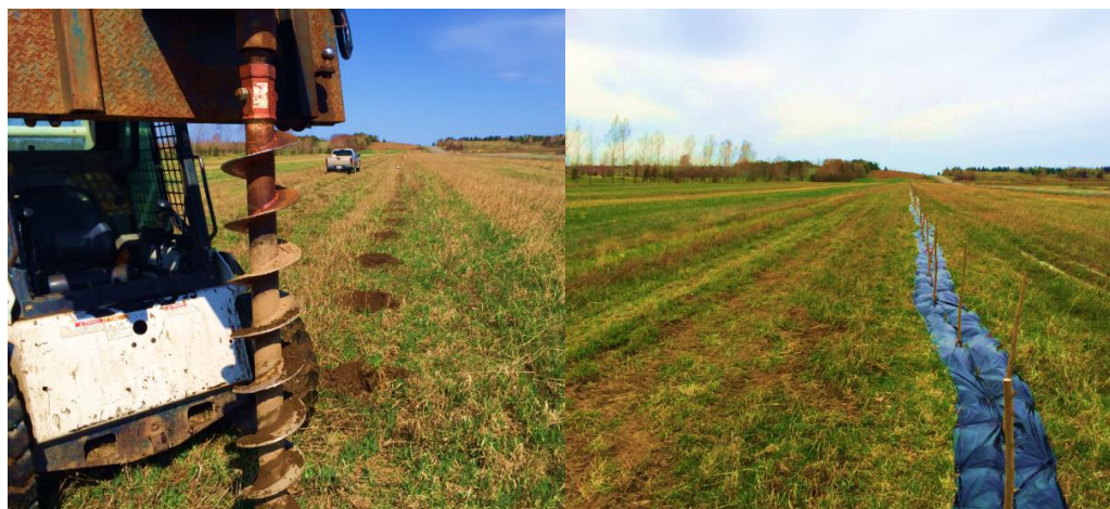
Figure 7 Implantation de la haie 17 à l'aide d'une tarière mécanique (avant et après)
