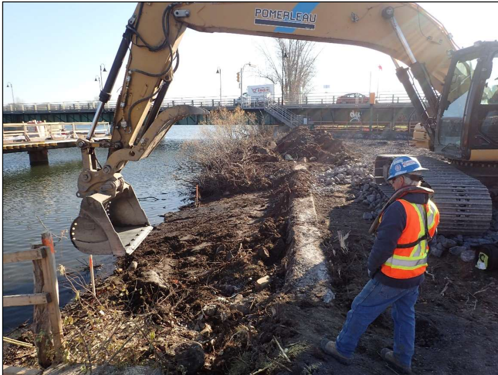
Figure 58 : Projet 154-09-0425, site 580G, sous-opération 10E, vestige du mur est de l'îlot 580G10E102), vers le sud (photo ARTE4-PB150139).
