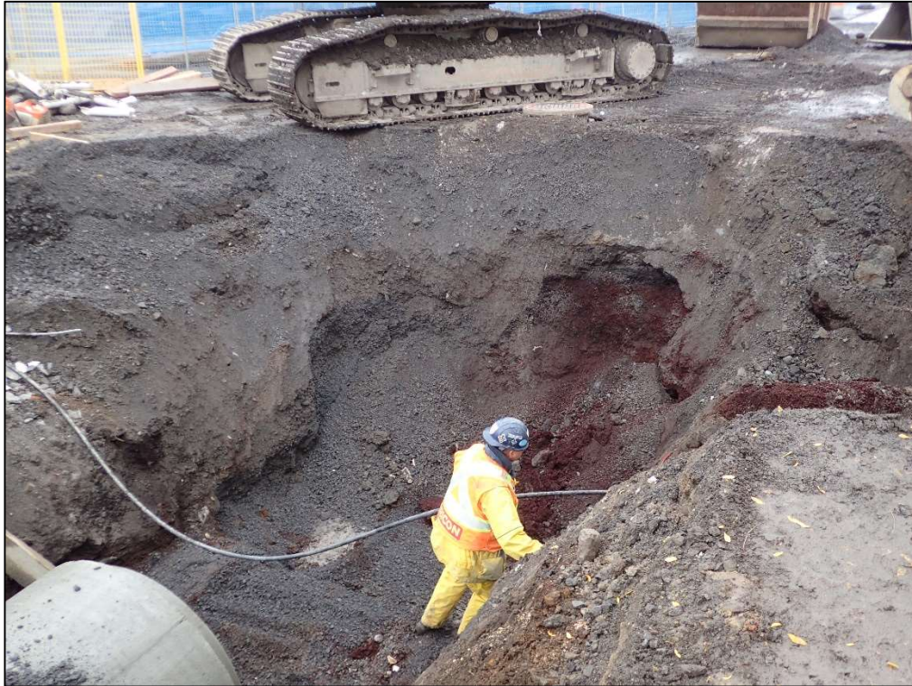
Figure 72 : Projet 154-09-0425, site SJ1, sous-opération 1B, vue générale des excavations, vers le sud-est (photo ARTE4-PA260043).
