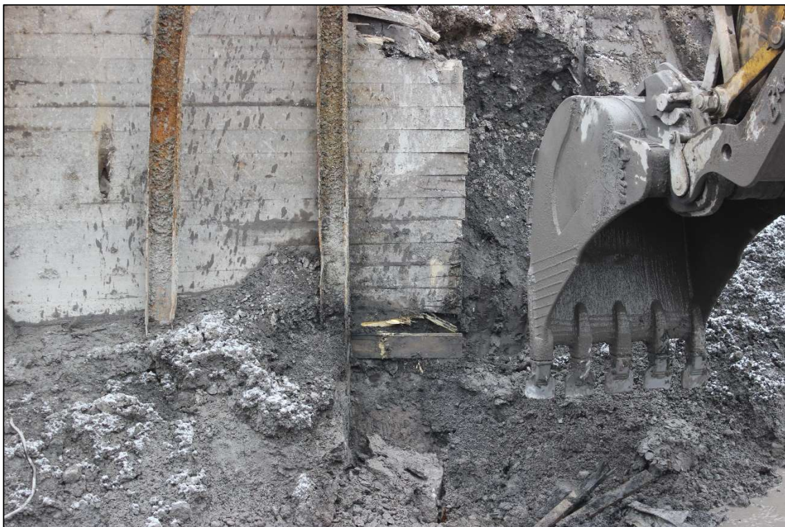
Figure 53 : Projet 154-09-0425, site 580G, sous-opération 10E, extrémité sud du vestige 580G10E200, vers l'est (photo WIER-0082)
