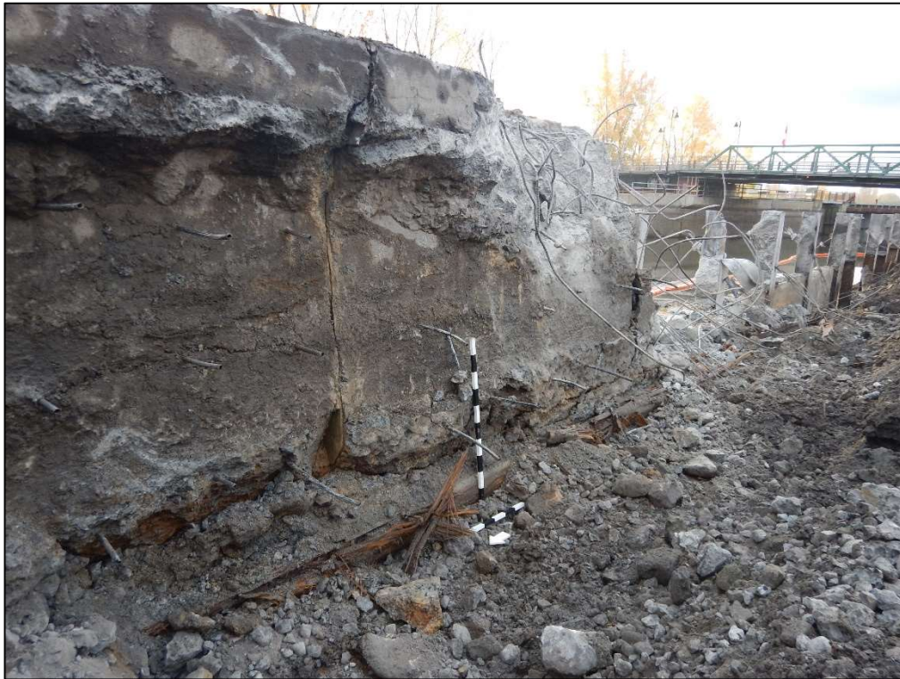
Figure 37 : Projet 154-09-0425, site 580G, sous-opération 9E, radiers sous le mur 580G9E100 et poutres en H formant son squelette (photo LAFR-DSCN6068).
