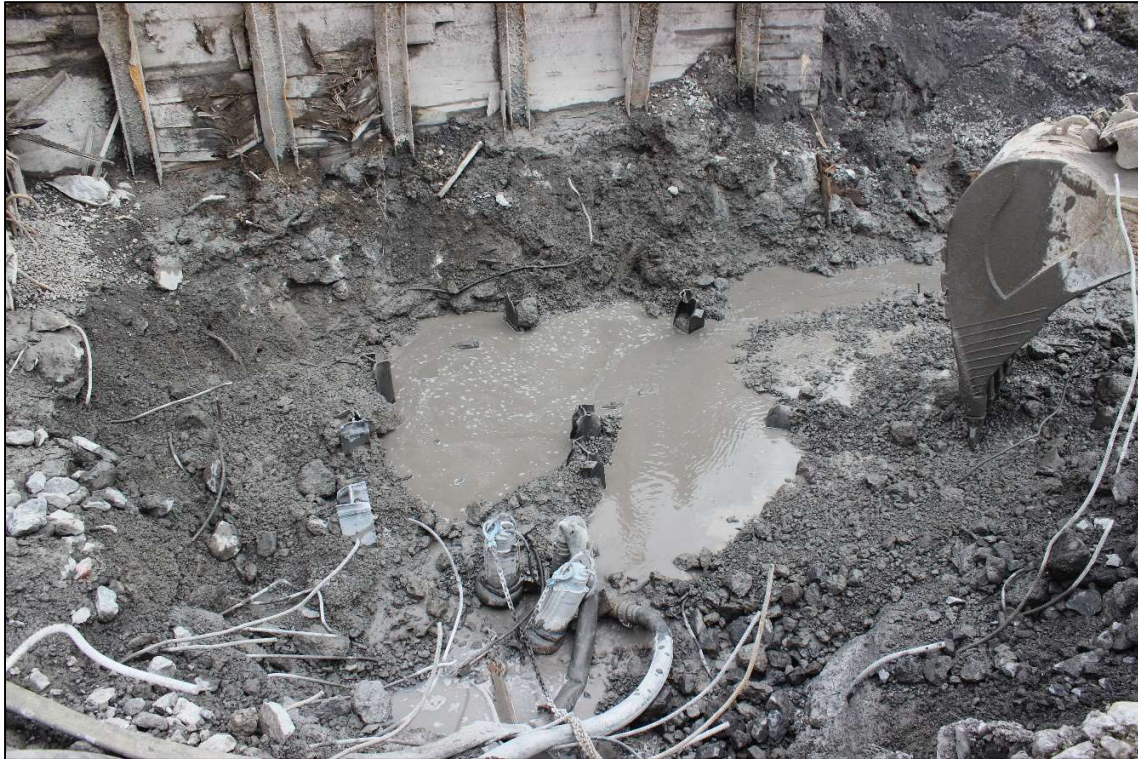
Figure 50 : Projet 154-09-0425, site 580G, sous-opération 10A, démolition de la base du mur 580G10A100, vers l'est (photo WIER-0046).
