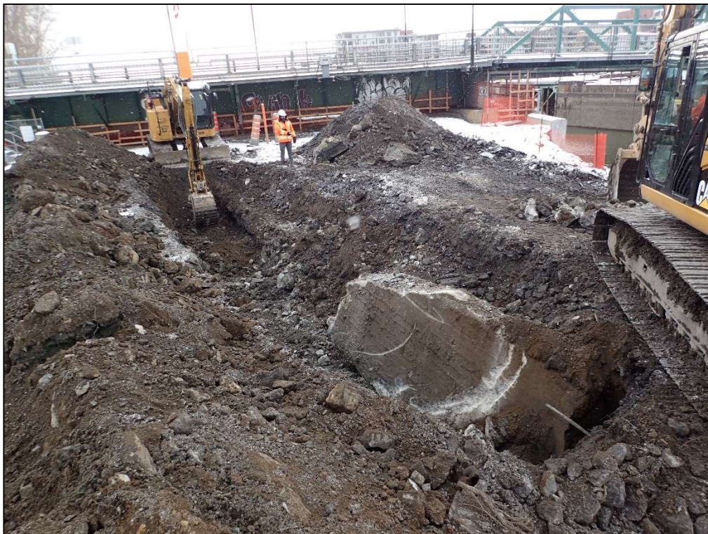
Figure 57 : Projet 154-09-0425, site 580G, sous-opération 10E, parement est du vestige 580G10E100 lors de sa démolition, vers le sud-ouest (photo ARTE4-PB270160).
