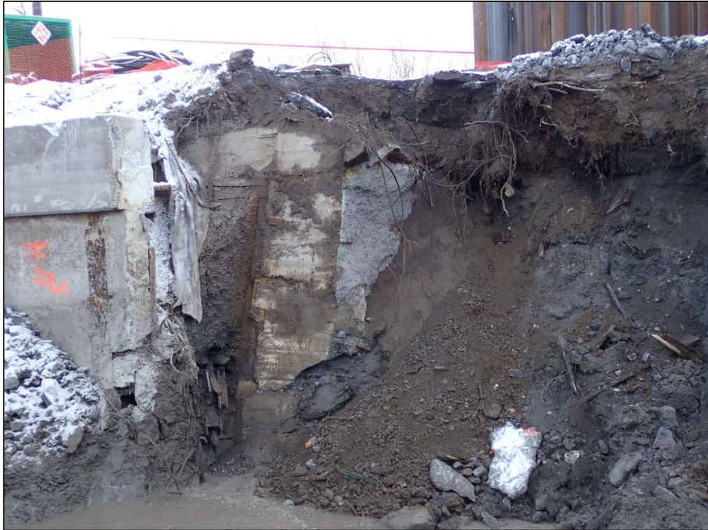
Figure 54 : Projet 154-09-0425, site 580G, sous-opération 10E, blocs de béton derrière le vestige 580G10E200, vers le nord-est (photo ARTE4-PC110234).
