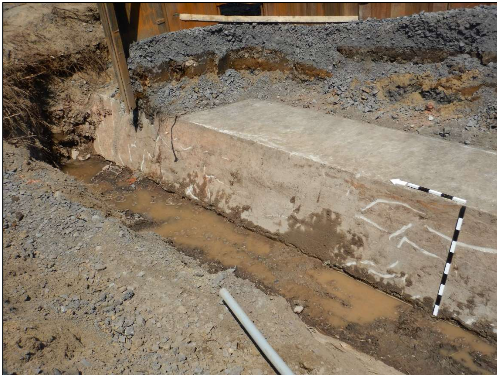
Figure 67 : Projet 154-09-0425, site 580G, sous-opération 8A, parement ouest du vestige 580G8A100, vers le nord-est (photo LAFR-DSCN5277).
