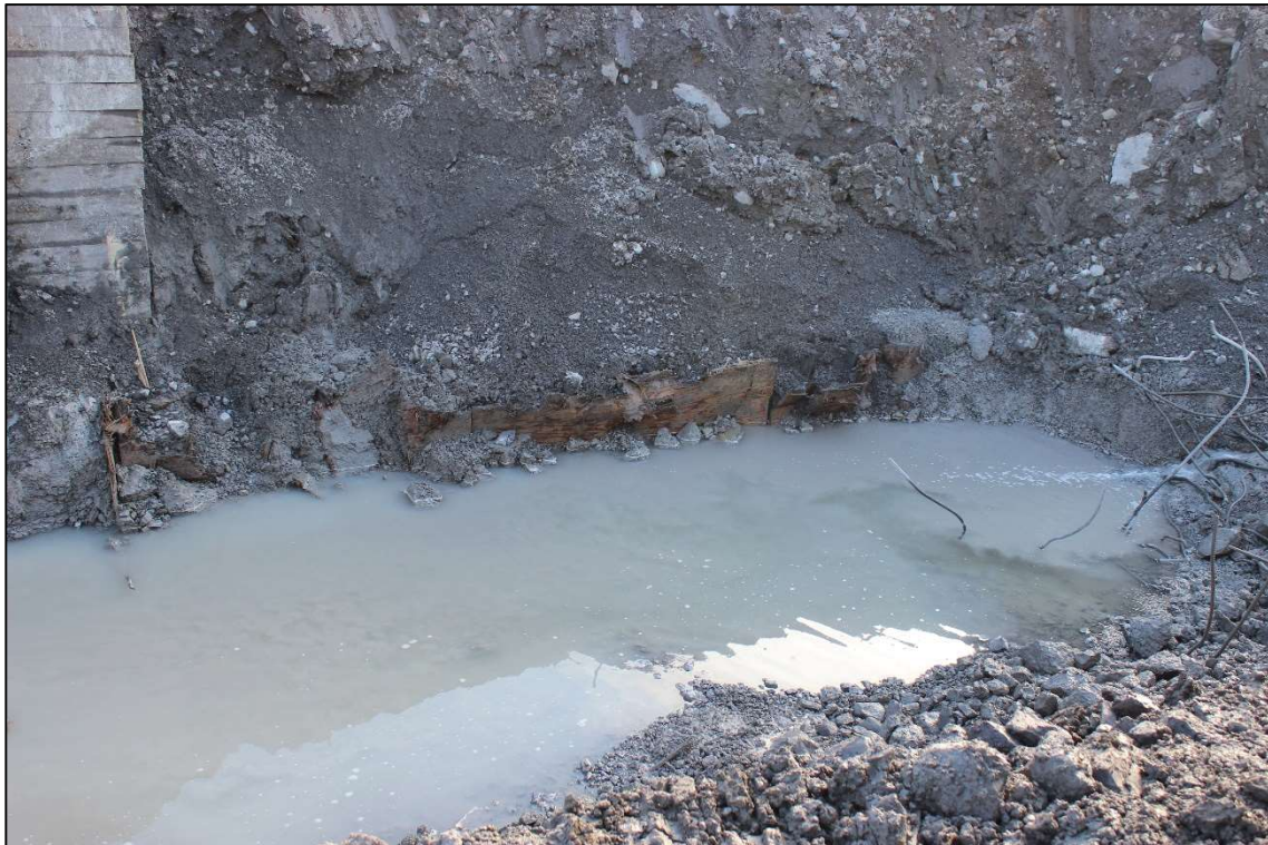
Figure 51 : Projet 154-09-0425, site 580G, sous-opération 10A, coffrage de la base de béton de 580G10A100, vers le sud-est (photo WIER-0041).
