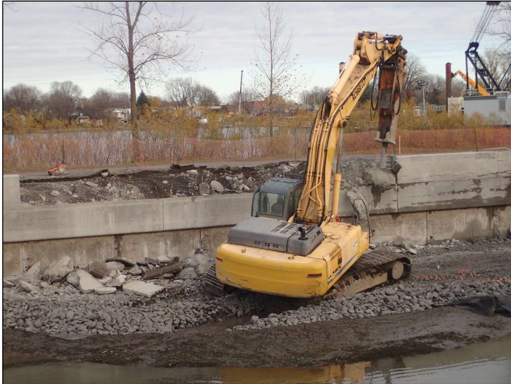
Figure 48 : Projet 154-09-0425, site 580G, sous-opération 10A, démolition de la section nord du mur 580G10A100, vers le sud-est (photo ARTE4-PB080100).
