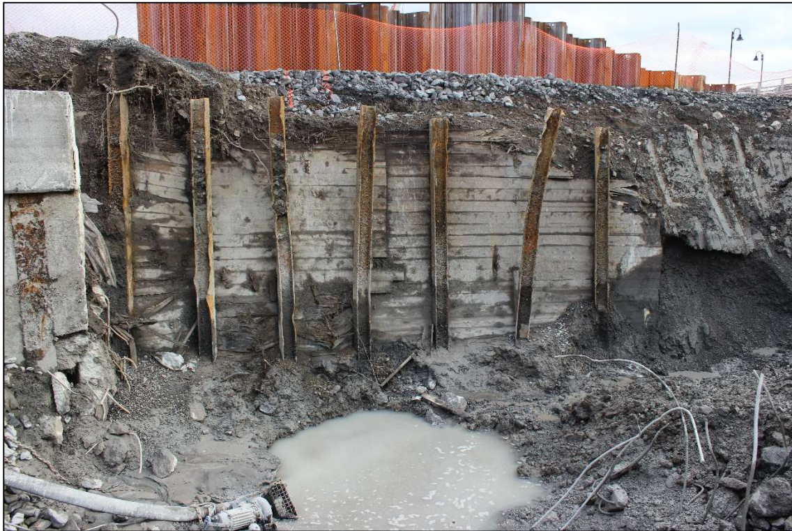
Figure 52 : Projet 154-09-0425, site 580G, sous-opération 10E, vestige du mur berlinois 580G10E200, vers l'est (photo WIER-0019).
