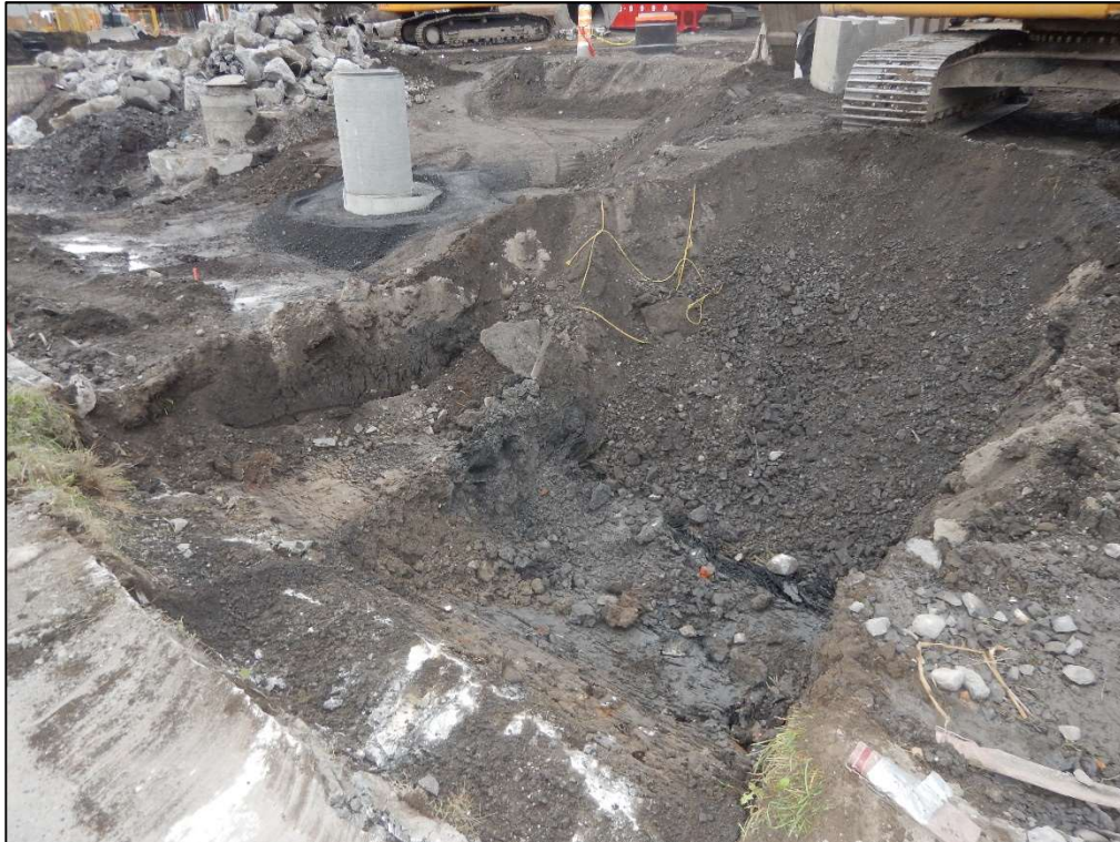
Figure 33 : Projet 154-09-0425, site 580G, sous-opération 9E, remblais remaniés jusqu'au niveau d'argile, vers le sud-ouest (photo LAFR-DSCN6017).
