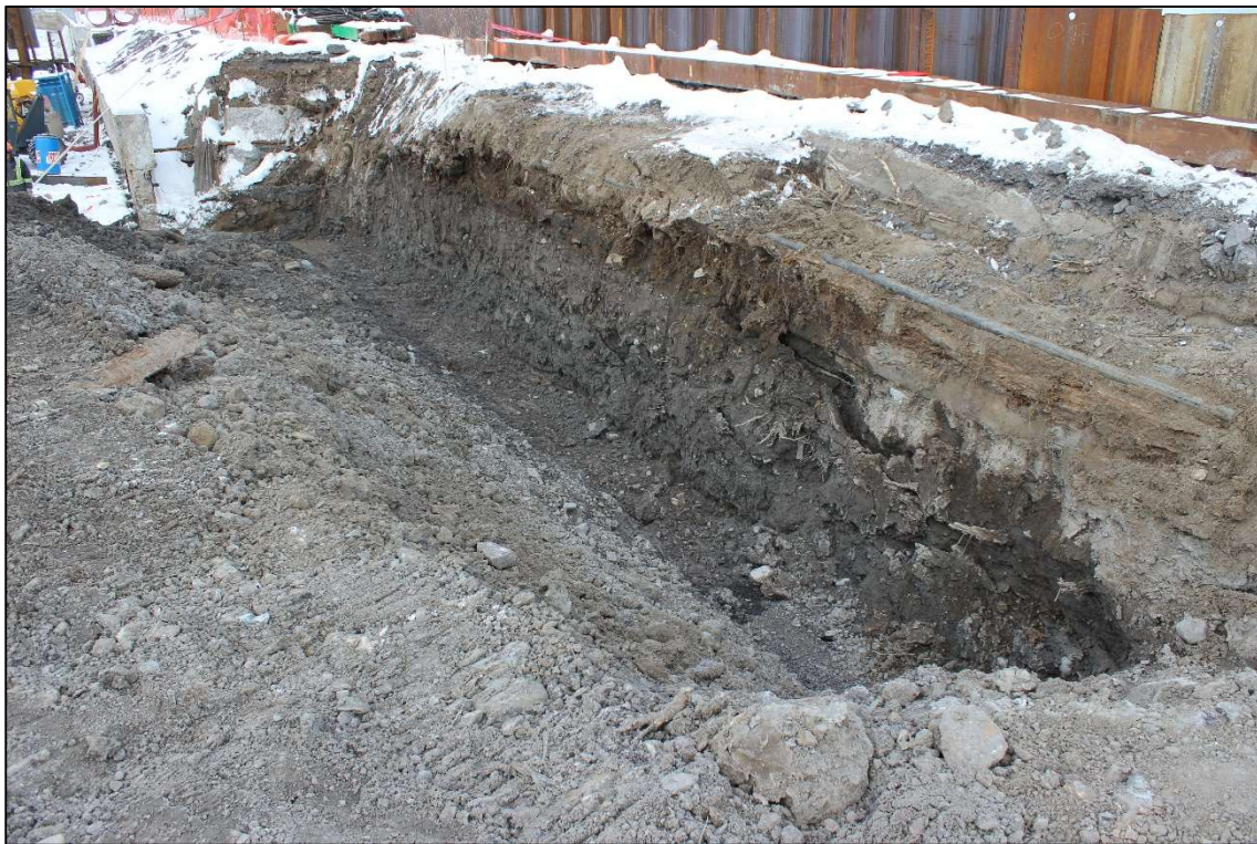
Figure 47 : Projet 154-09-0425, site 580G, sous-opération 10J, paroi est de la tranchée, vers le nord-est (photo WIER-0126).
