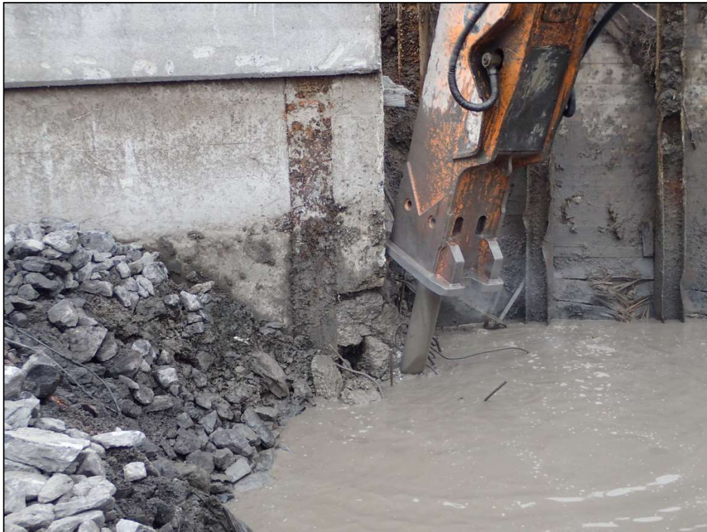
Figure 64 : Projet 154-09-0425, site 580G, sous-opération 10A, jonction entre la partie nord et la partie sud de 580G10A100, vers le sud-est (photo ARTE4-PC020220).
