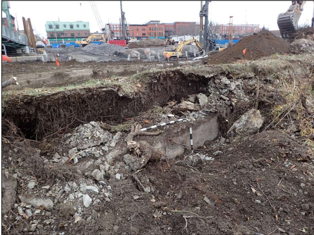
Figure 60 : Projet 154-09-0425, site 580G, sous-opération 10E, parement est du vestige 580G10E102, vers le nord-ouest (photo ARTE4-PB140117).
