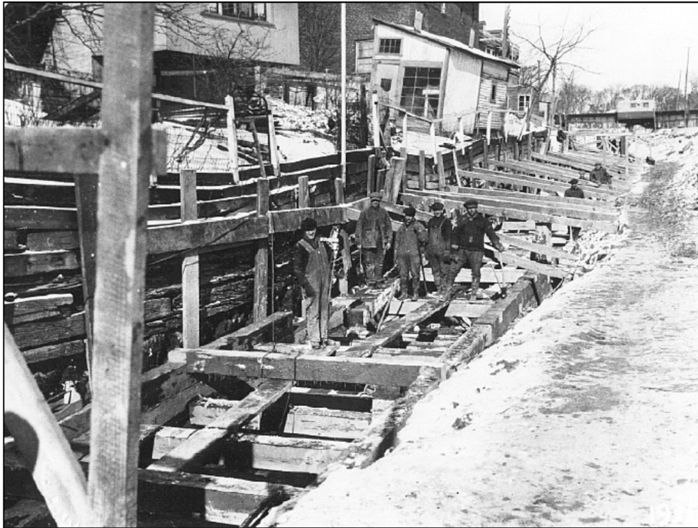
Figure 41 : Vue des travaux de construction du cribwork de 1930 au sud de la rue Foch (source : Cloutier 1999 : 24).
