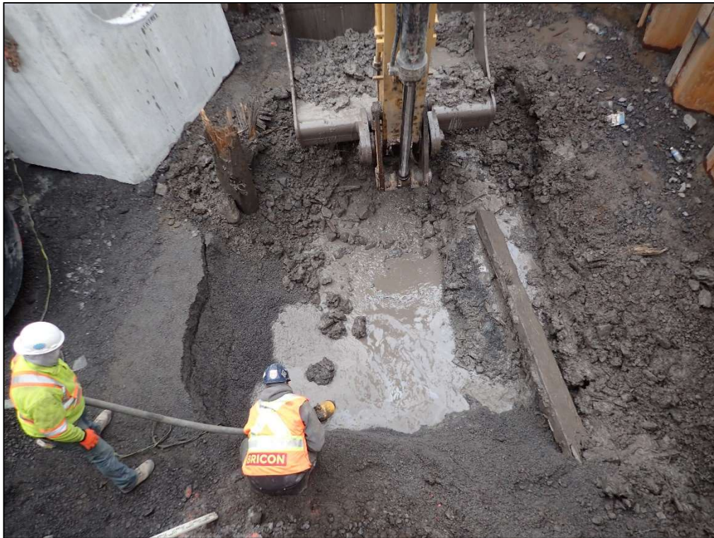
Figure 70 : Projet 154-09-0425, site 580G, sous-opération 8B, dégagement mécanique de pièces de bois, vers le sud (photo ARTE4-PB140121).
