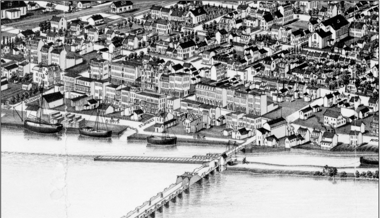
Figure 12 : Vue aérienne du secteur de la rue Richelieu en 1881 (source : BAC, H12/340/Saint Jean/1881, NMC1951).
