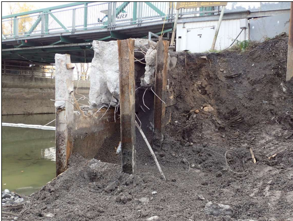
Figure 42 : Projet 154-09-0425, site 580G, sous-opération 9E, fondations de la maison de l'éclusier (580G9E102) et d'un ancien mur berlinois (580G9E202), vers le sud-est (photo ARTE4-PA270055).
