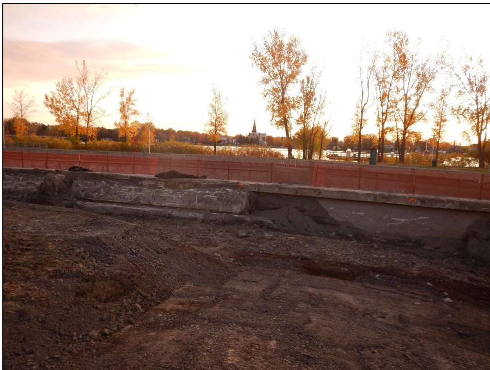
Figure 36 : Projet 154-09-0425, site 580G, sous-opération 9E, parement ouest du mur du canal 580G9E100 (photo LAFR-DSCN5953).
