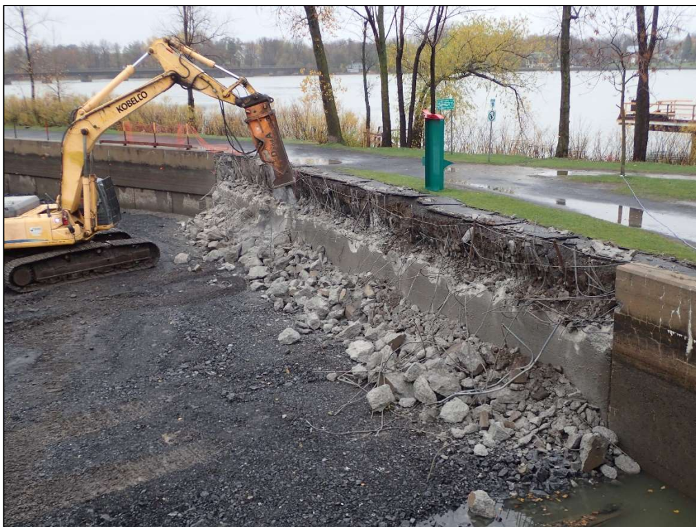
Figure 49 : Projet 154-09-0425, site 580G, sous-opération 10A, démolition de la section sud du mur 580G10A100, vers le nord-est (photo ARTE4-PB060063).
