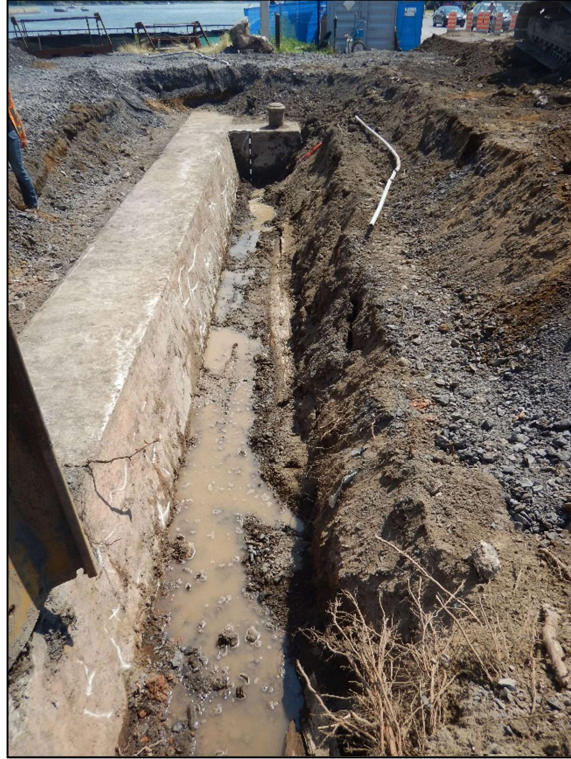
Figure 66 : Projet 154-09-0425, site 580G, sous-opération 8A, vestige de l'ancien mur ouest du canal 580G8A100, vers le sud (photo LAFR-DSCN5283).
