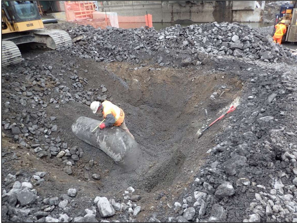
Figure 46 : Projet 154-09-0425, site 580G, sous-opération 10H, vue générale de l'excavation, vers l'ouest (photo ARTE4-PB170151).
