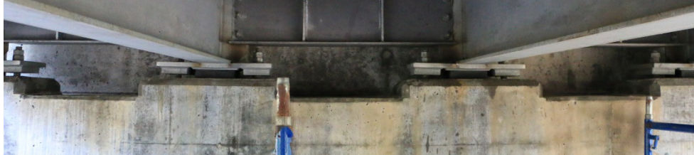
Figure 2.14 Vue des assises du pont Saint-Ambroise (Centre de recherche sur l'aluminium -REGAL)
