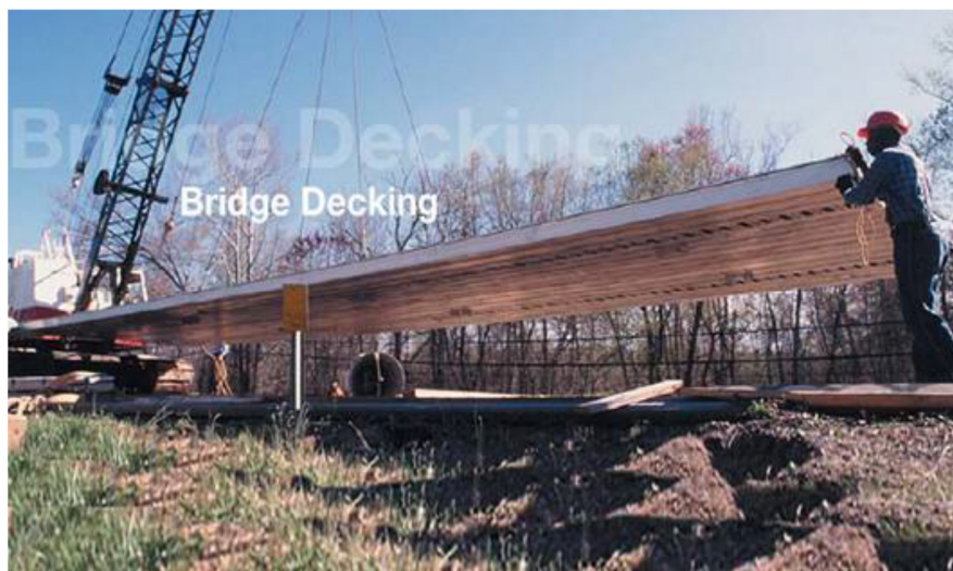
Figure 2.1 Mise en place d'un platelage en aluminium (SAPA Group)
