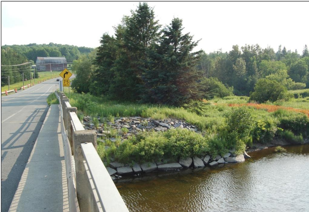
Photo 28    Projet no 154-00-195, empierrement du côté sud-ouest du pont, direction ouest (PATR12N02-2)
