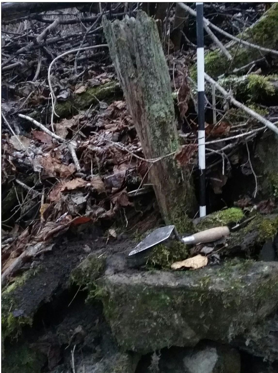
**Photo 14 : Projet 154-01-0179, zone #4, poteau retenant les pierres du mur de soutien (source : #1478811098875)**
