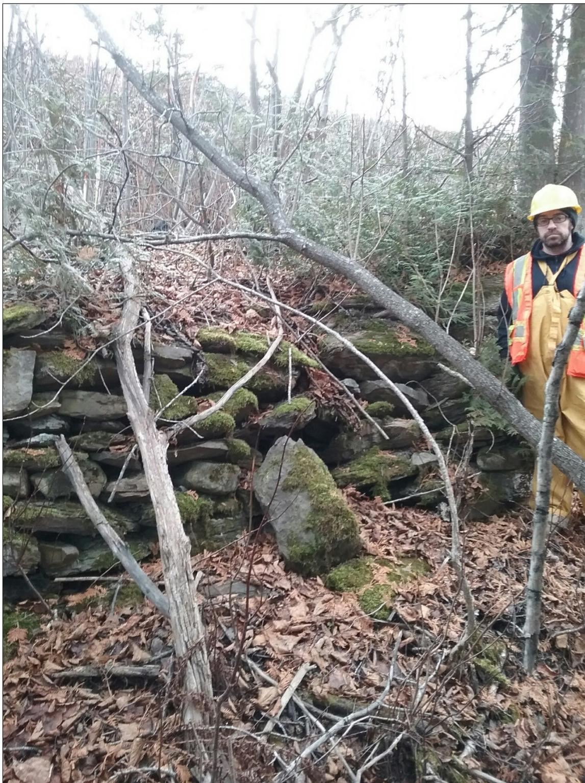
**Photo 3 : Projet 154-01-0179, zone #1, mur de soutien en pierres sèches (source : #1478784322357)**
