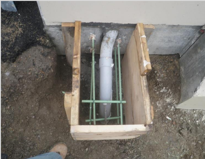
11.3 Electrical conduit exiting barrier.
