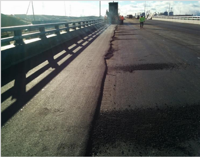
17.9 Unacceptable, uneven longitudinal joint.
