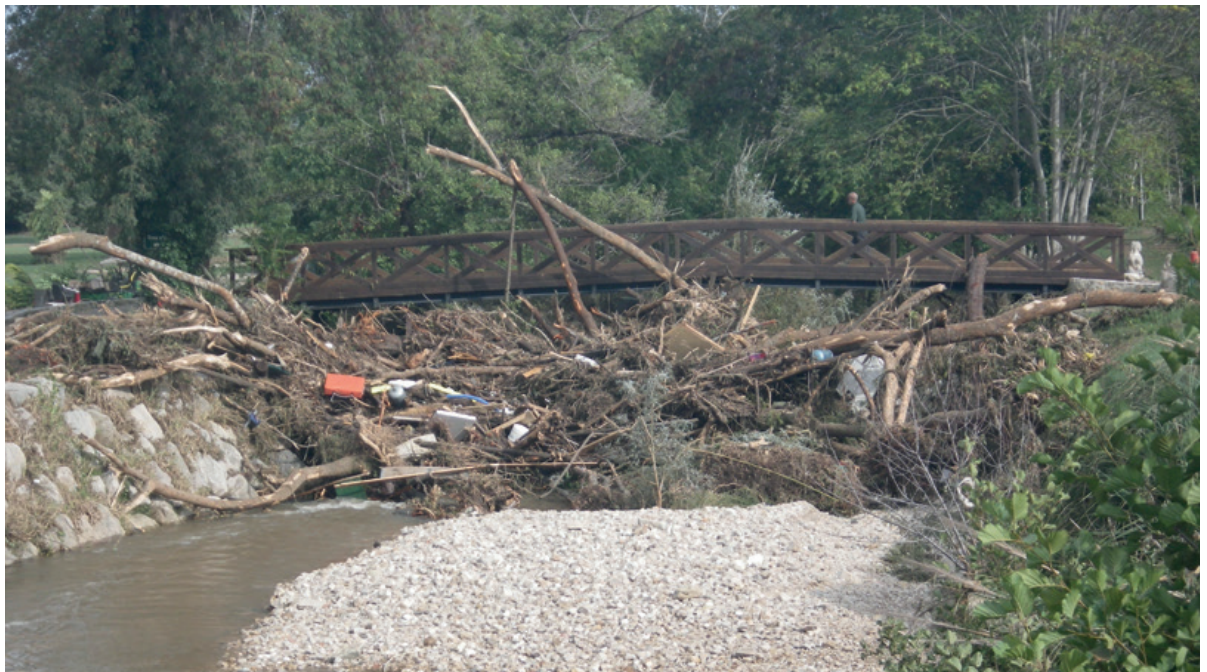
Inondations octobre 2015 - Crue de La Brague. Photo : Dreal PACA
