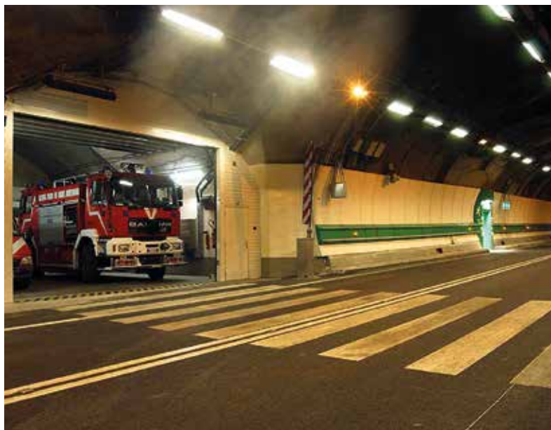
Restructuration du tunnel du Mont-Blanc après la catastrophe du 26 mars 1999. Photo : Cetu
