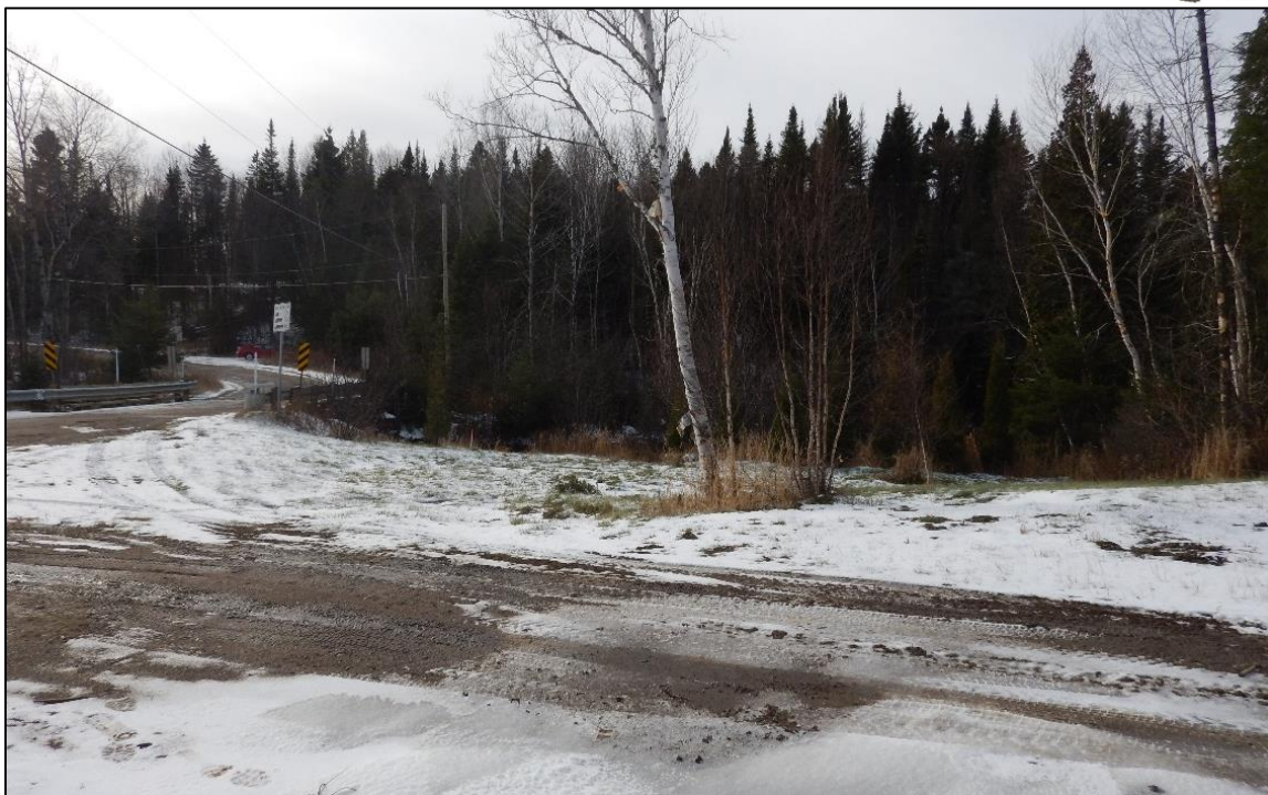
Photo 5 : Projet 154-08-1323, secteur aménagé par le nivellement de la topographie naturelle, la mise en place d'un chemin d'accès avec gravier et un aménagement paysager, secteur 2, direction ouest.
