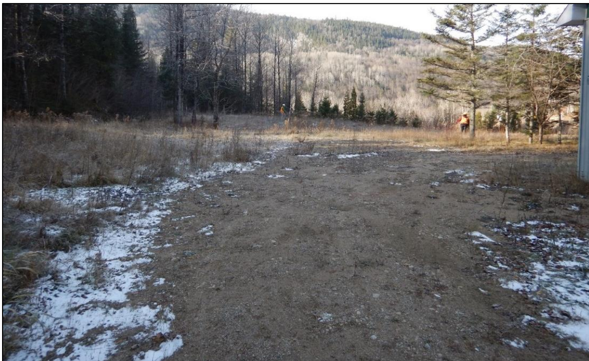
Photo 19 : Projet 154-08-1323, secteur 2, chemin d'accès pour véhicule motorisé avec revêtement en concassé ceinturant le bâtiment, partie localisée derrière le bâtiment, direction ouest.
