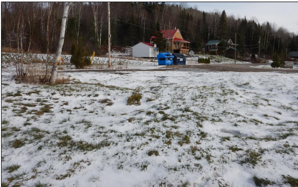
Photo 6 : Projet 154-08-1323, secteur aménagé par le nivellement de la topographie naturelle, la mise en place d'un chemin d'accès avec gravier et un aménagement paysager, secteur 2, direction est sud-est.
