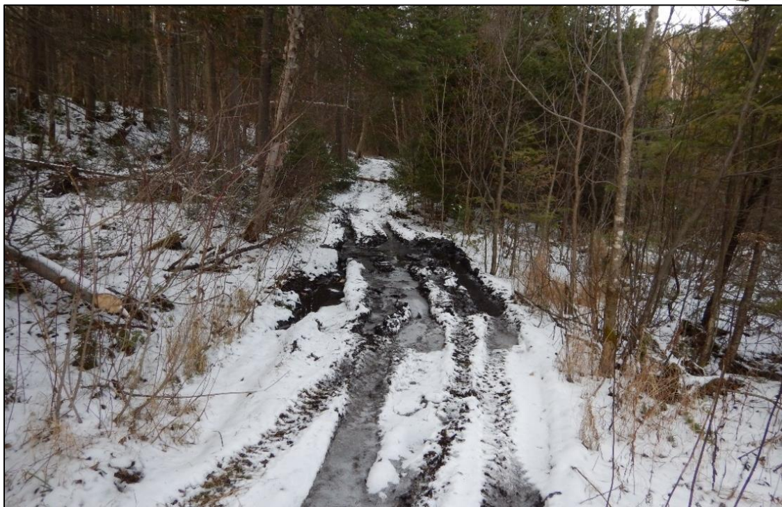
Photo 3 : Projet 154-08-1323, second chemin d'accès évoluant à l'intérieur du secteur 1, direction nord-ouest.
