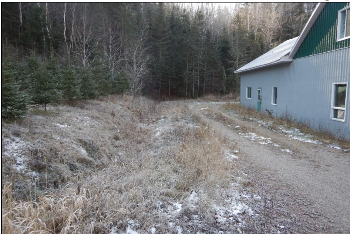
Photo 18 : Projet 154-08-1323, secteur 2, chemin d'accès pour véhicule motorisé avec revêtement en concassé ceinturant le bâtiment récent, partie du secteur à l'est du bâtiment, direction sud.
