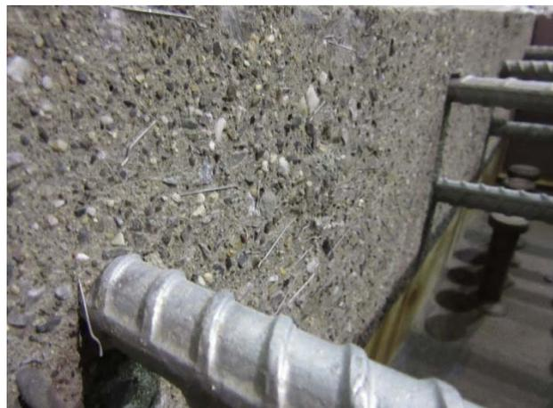
**Figure 2-9** : Préparation des surfaces des dalles préfabriquées
