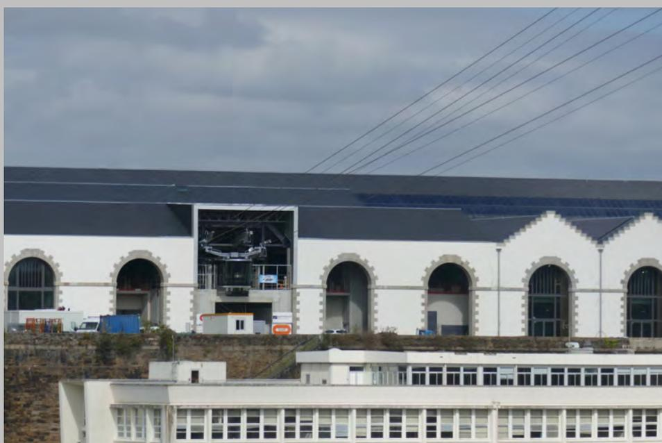
Initialement, sur la rive gauche, il était proposé de créer une station souterraine<sup>21</sup> au niveau du soutènement de la route. Or de fortes contraintes techniques et financières sont apparues. Finalement, mi-2014, une autre solution en encorbellement est retenue qui permet de diminuer le coût d'investissement et la complexité du chantier.
