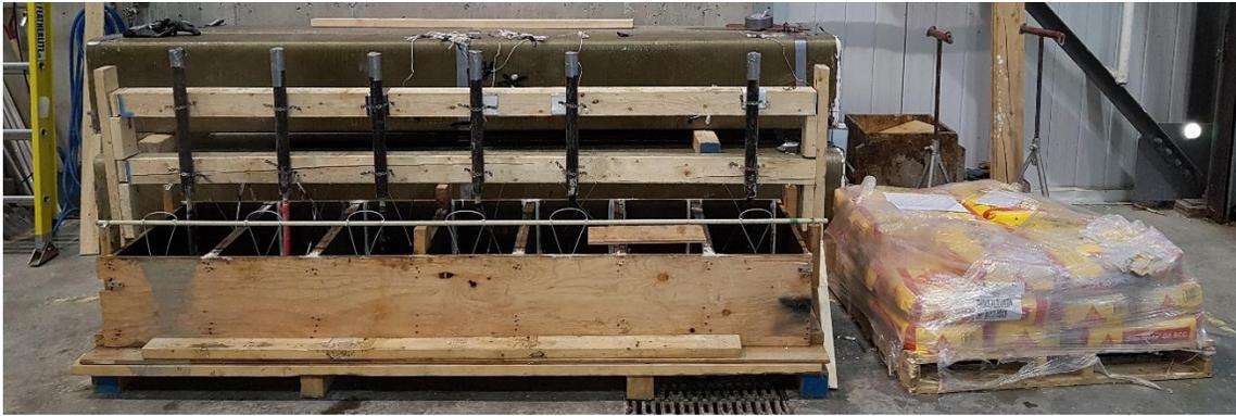
*(a) Coffrages avant la coulée du béton*
