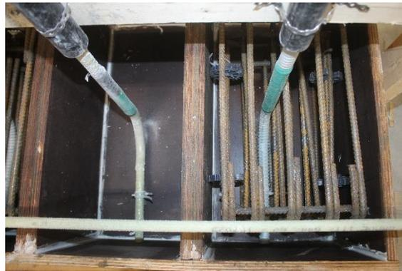
(c) Coffrages avec et sans cage d'armatures en acier
