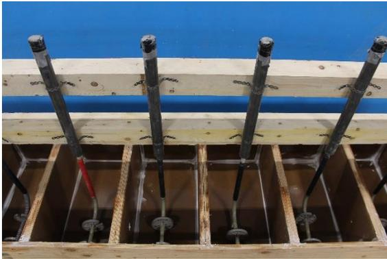
(a) Coffrages avant la coulée du béton
