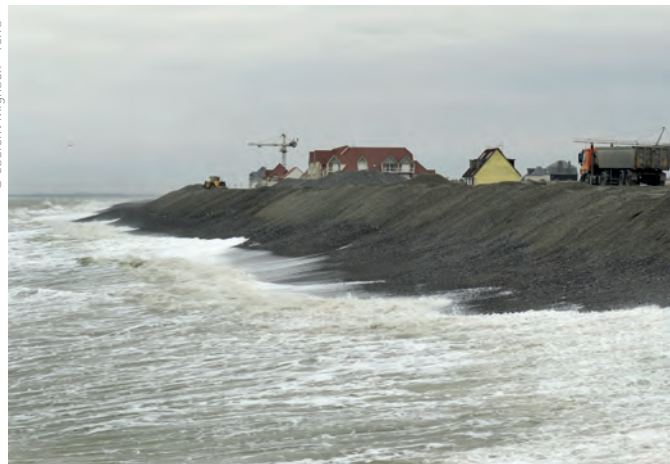
Cordon de galets de Cayeux : construction d'épis et apport artificiel de galets pour lutter contre l'érosion littorale
