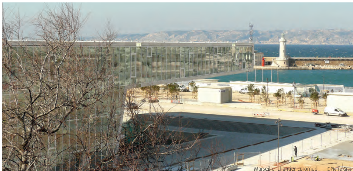
Marseille chantier Euromed ©Pierre Gras
