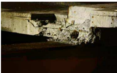
Figure 6.24 Section E-E – Forte corrosion avec désagrégation du béton
