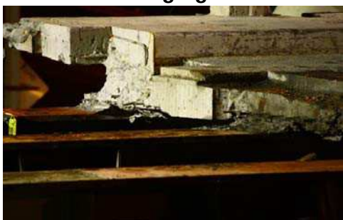
Figure 6.24 Section E-E – Forte corrosion avec désagrégation du béton
