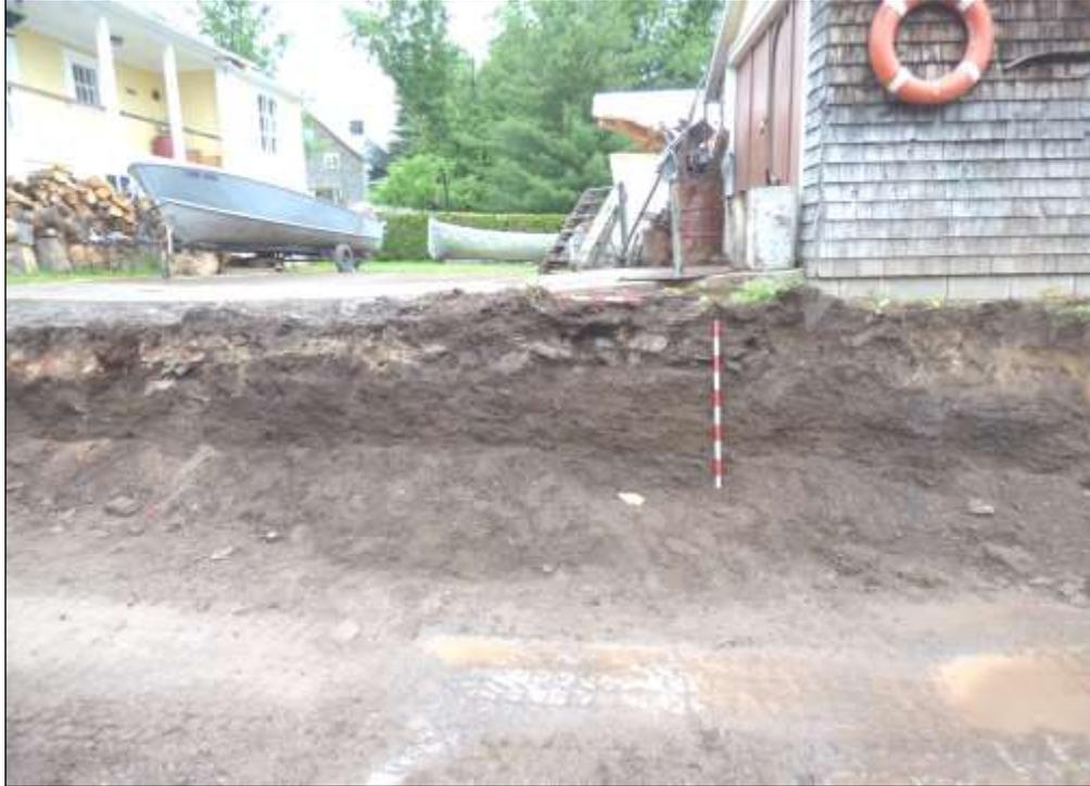
**Photo 28.** Vue rapprochée de l'émissaire 6 à la hauteur du chaînage 106+030. Dans la paroi est de la tranchée, on peut observer la présence d'un niveau de démolition contenant des pierres calcaires et du mortier au nord du garage, vers l'est (MTQ-1342-2016-152)
