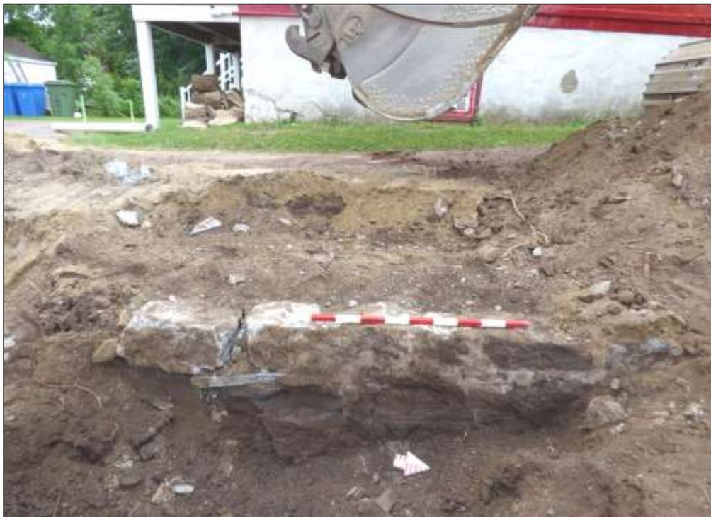
**Photo 31.** Vue rapprochée d'un muret de pierres associé à un canal de ruissellement identifié dans l'emprise de l'émissaire 7, à la hauteur du chaînage 107+020, vers l'ouest (MTQ-1342-2016-161)
