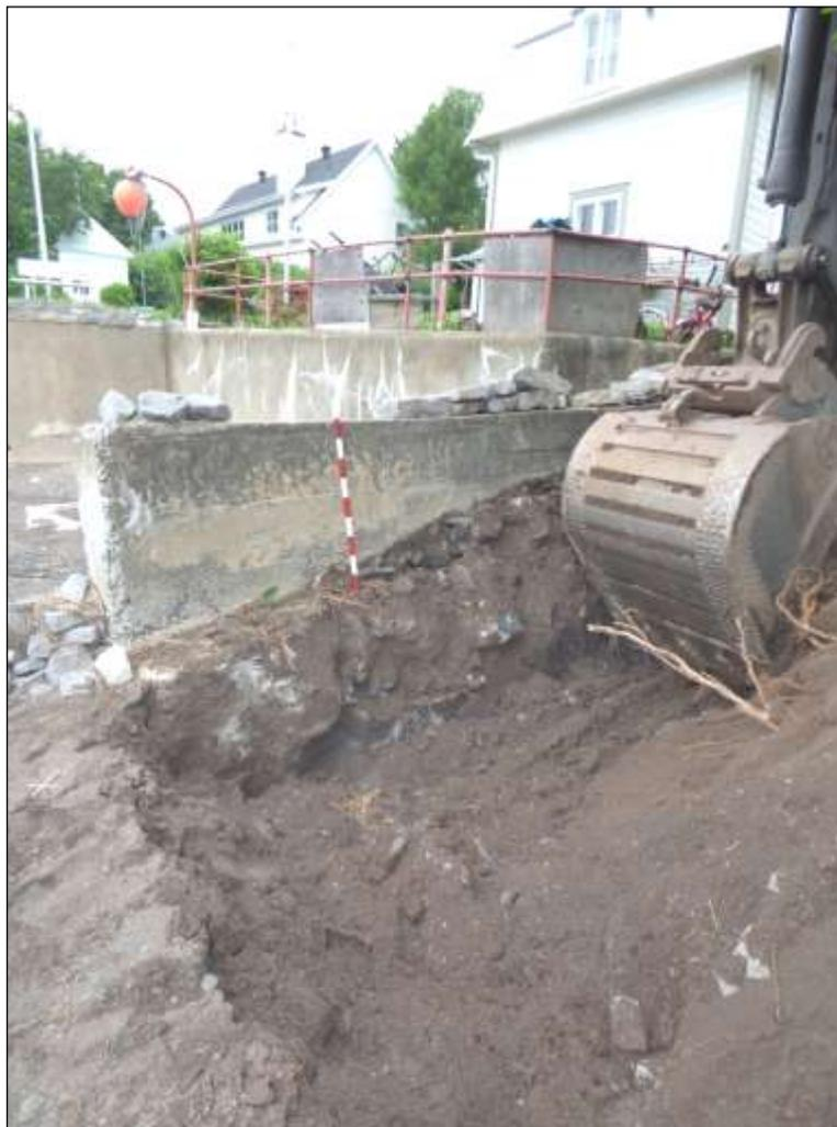
**Photo 27.** Vue rapprochée d'un muret de pierres associé à un canal de ruissellement identifié dans l'emprise de l'émissaire 6, à la hauteur du chaînage 106+070, vers l'ouest (MTQ-1342-2016-136)
