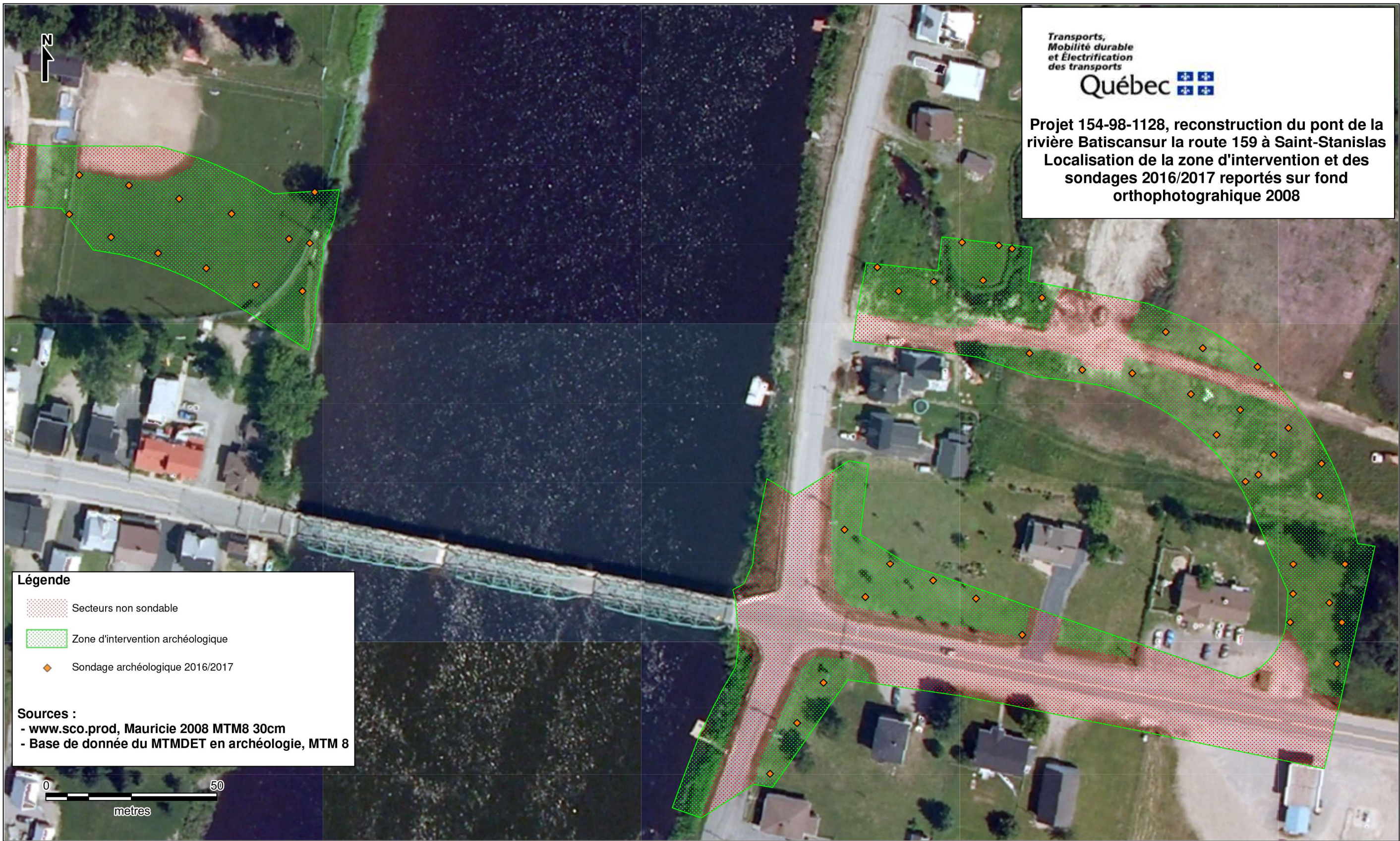
Figure 12 : Projet no 154-98-1128, localisation de l'emprise et des secteurs inventoriés, route 159, municipalité de Saint-Stanislas (source : MTMDET).
