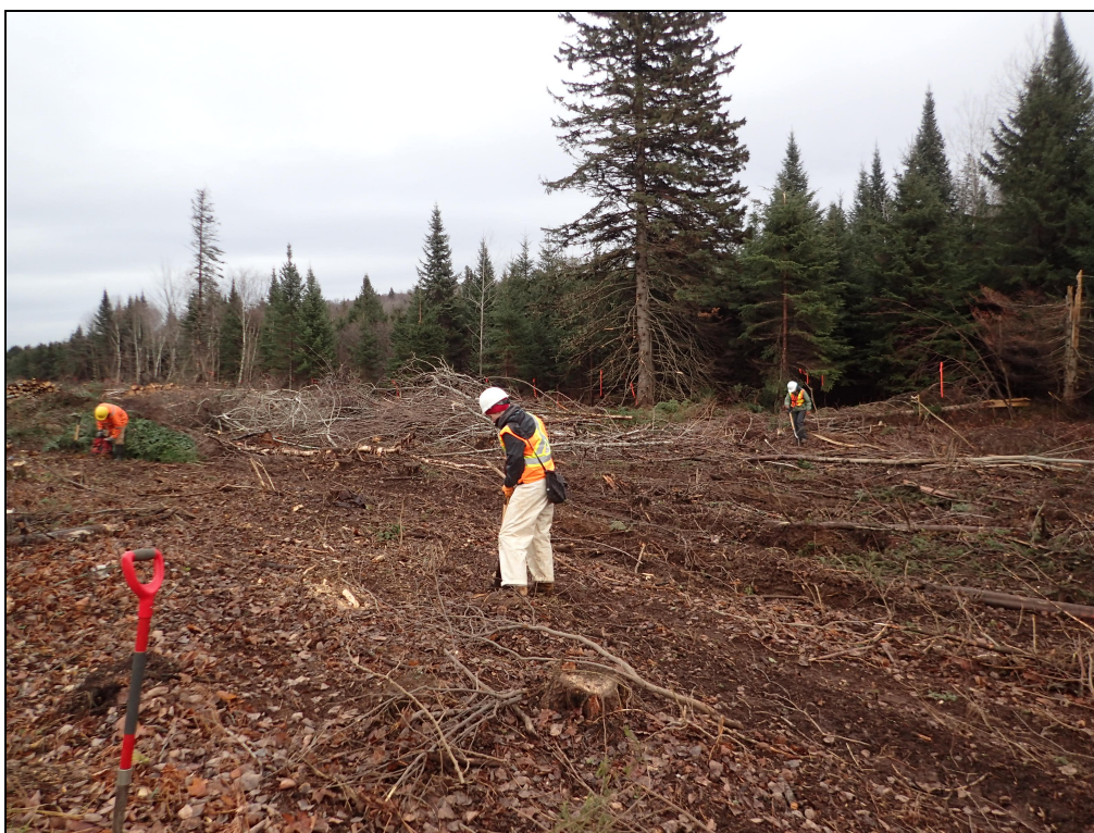
Figure 9 : Projet no 154-82-0089, secteur 1C, vue générale de l'emprise, vers le sud (photo 154-82-0089-9).
