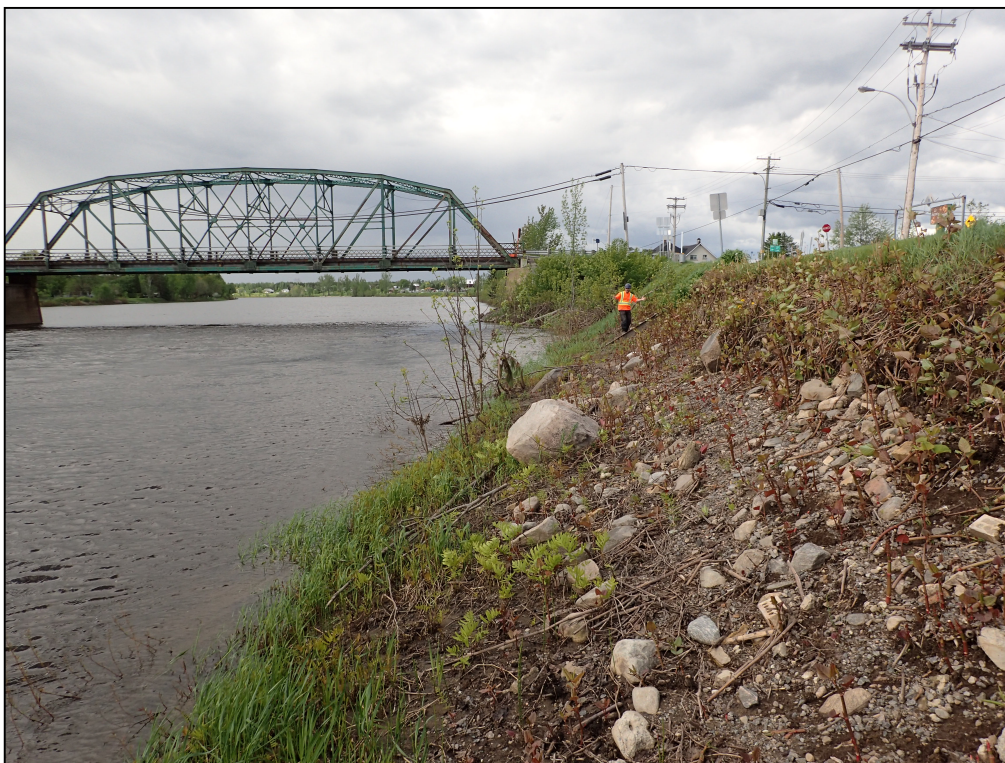
Figure 20 : Projet n° 154-98-1128, vue générale de l'emprise au sud du pont, le long de la rivière Batiscan, vers le nord (photo 154-98-1128-29).
