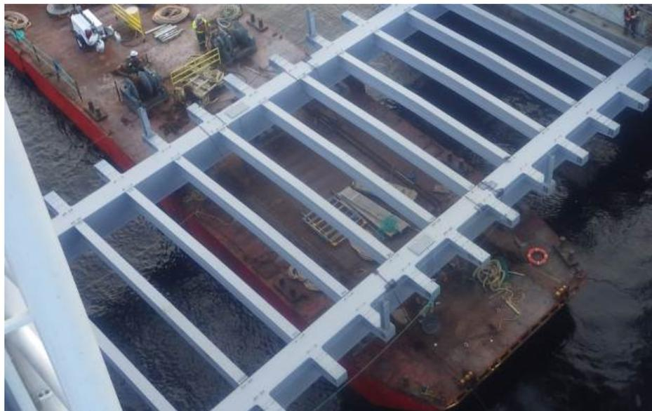
**Figure 12 – La charpente de la travée levante**
