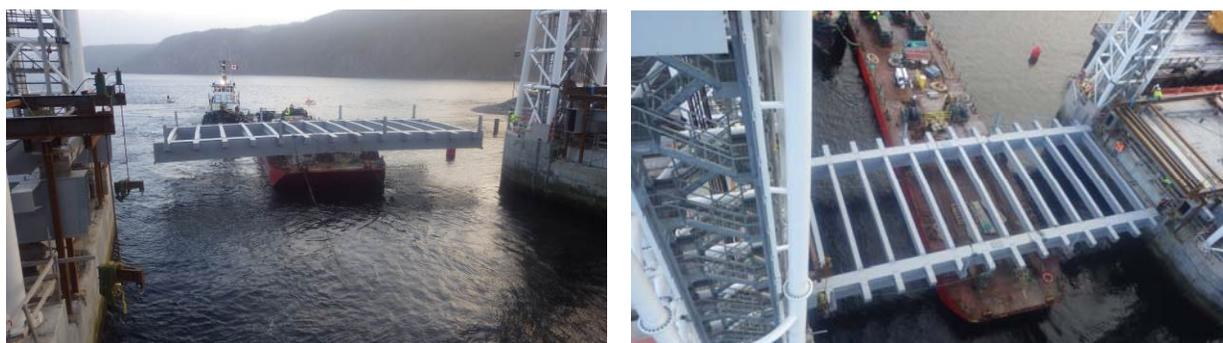
**Figure 17 – Déplacement de la travée levante jusqu'à sa position**
