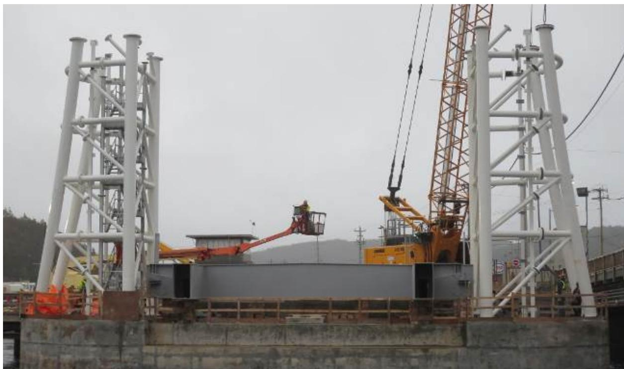
**Figure 16 – Assemblages boulonnés des tours**
