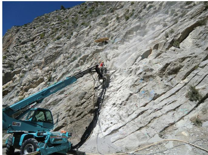
Figure 7 : Exemple de portage sur une nacelle du matériel de foration en station
