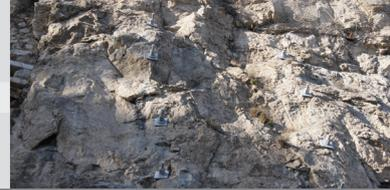
La contribution minimale nécessaire du renforcement  $F_{des} Y - H$  rapportée à la contribution unitaire d'un boulon  $C_b$  détermine le nombre de boulons arrondi à l'entier supérieur (notation  $\Lambda^{sup}[-]$ ). Cette contribution  $C_b$  représente l'apport direct de la barre en tant qu'effort de traction et de cisaillement dans l'équilibre passif du bloc, auquel s'adjoint un effet supplémentaire dû au frottement et à la dilatance.
