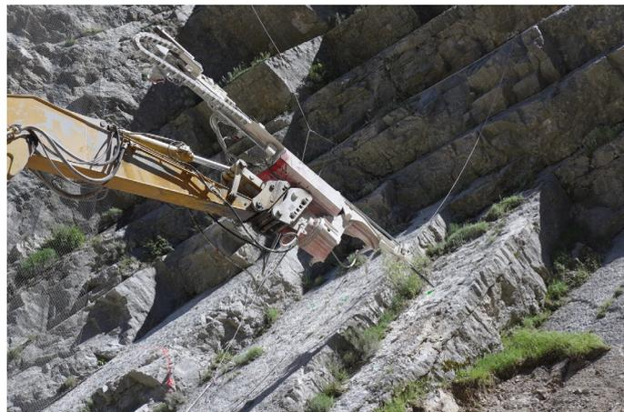
Figure 8 : Exemple de portage à l'aide d'un bras hydraulique du matériel de foration en station
