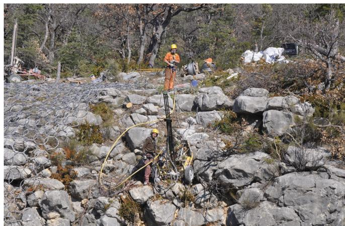
Figure 9 : Exemple de portage à l'aide d'un CFL du matériel de foration en station
