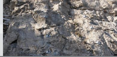
Les coulis utilisés dans les applications géotechniques pour le scellement des aciers d'ancrage ou de boulon suivent le référentiel défini pour le scellement des câbles de précontrainte dans le domaine des ouvrages d'art. Les normes sont celles du référentiel de la précontrainte :
