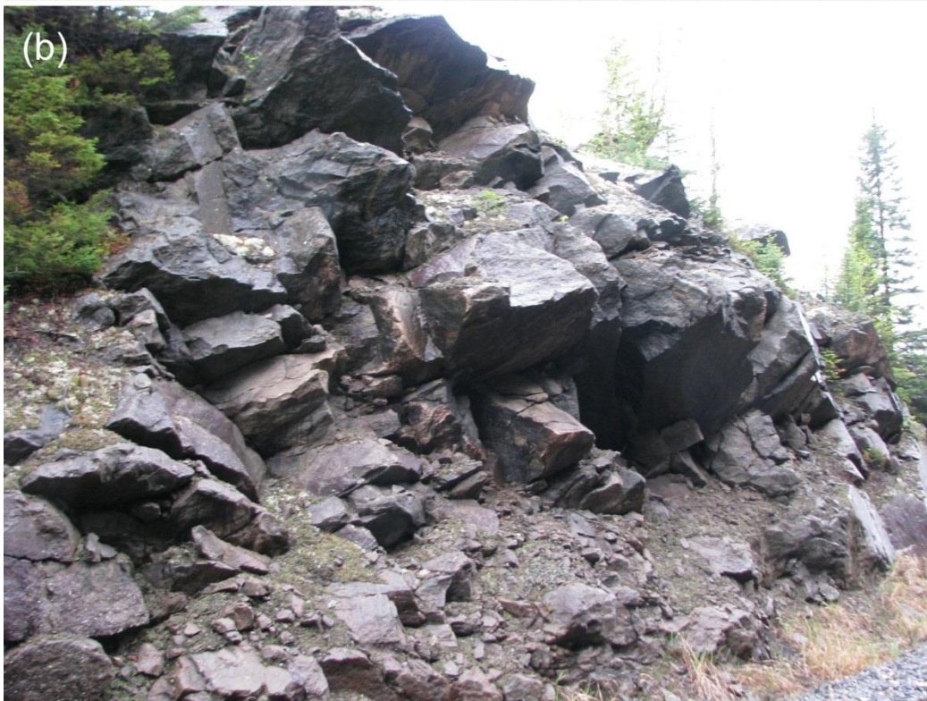
Figure 6.36. Exemple d'une coupe (a) où le mode de rupture est clairement identifiable (planaire) et (b) à la coupe de roc (E7 W, PM 69.1) il ne l'est pas et on y trouve surtout des surplombs (mode associé surtout à des chutes de pierres, Mayers 2017).
