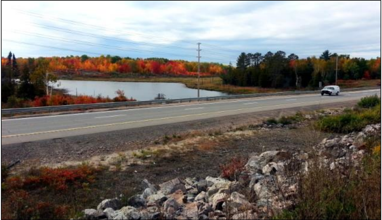
Route 11 en direction nord, à North Bay (photo prise par Rick Moore, MTO)
