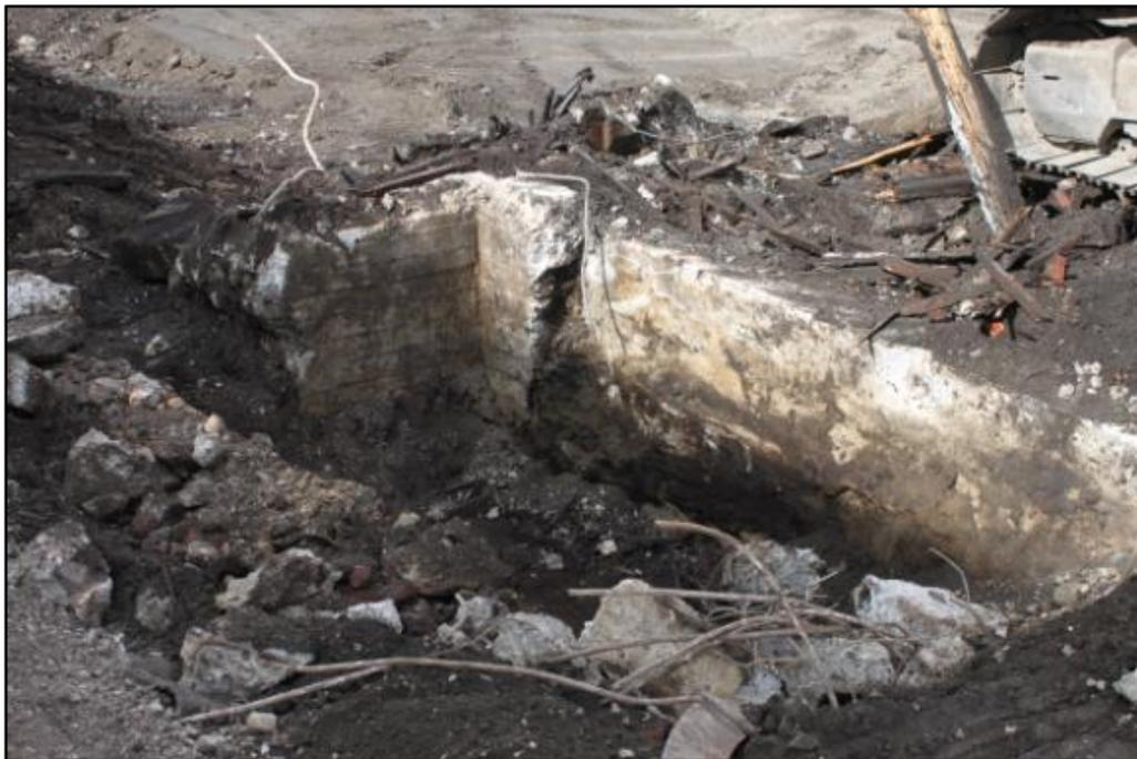
Photo 2 Deux périodes de construction sont visibles, caractérisées par les traces laissées par les formes de bois. Vue vers l'ouest (PATR14N08-039).
