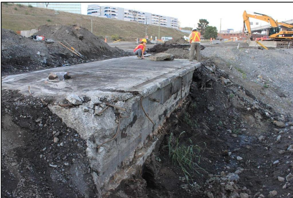
Photo 17 Profil d'un muret d'un puits d'entretien. Vue vers le nord (PATR14N09-056).
