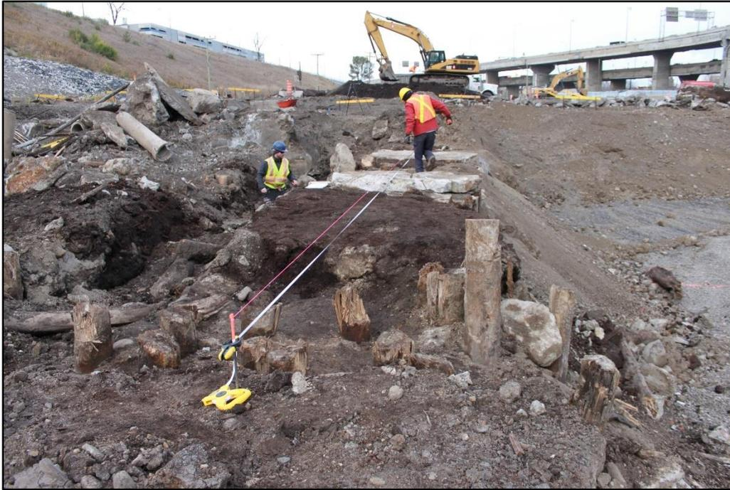
Photo 10 Vestige 1C306. Ici, la dalle a presque entièrement disparu, ne laissant que les pieux de bois formant la fondation sur pilotis. Vue vers le nord-est (PATR14N09-717).
