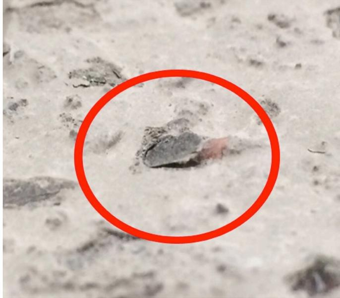
Figure III-16 Présence de feuillets en surface due à un « pop-out »
