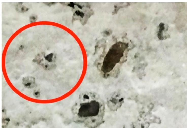
Figure III-19 Taille minimale d'éclatement de 5 mm
