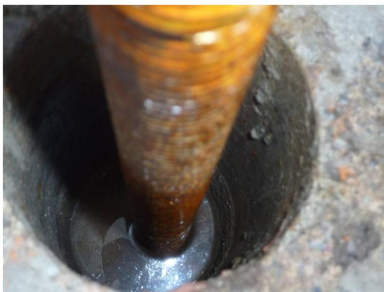
Figure 4.15 – Installation des barres d'ancrage
