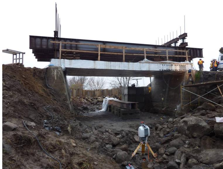
**Figure 4.2 - Excavation de la chaussée et des abords du pont**
