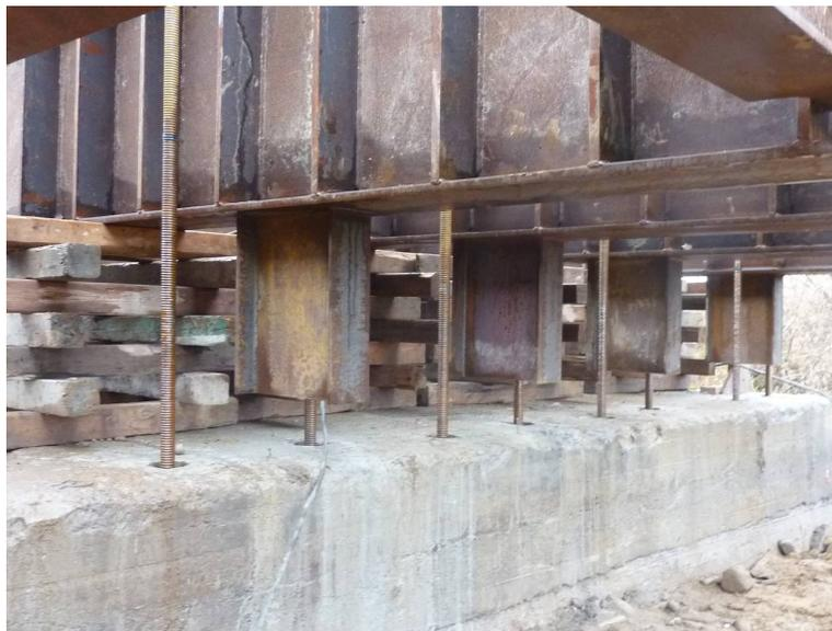
Figure 4.14 – Disposition des barres d'ancrage à l'extrémité opposée aux vérins
