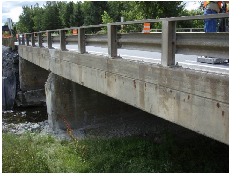
Figure 2.9 – Élément de retenue et côtés du pont refaits
