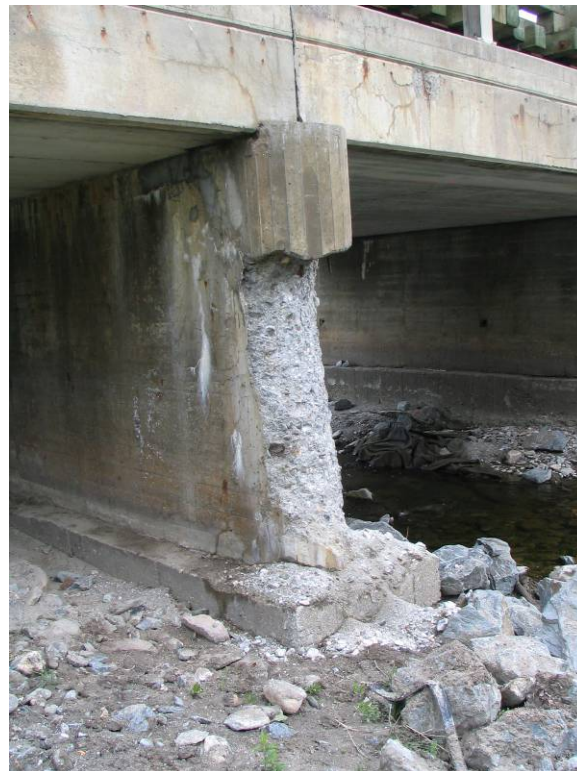
Figure 2.7 – Vue de la pile (Face aval)
