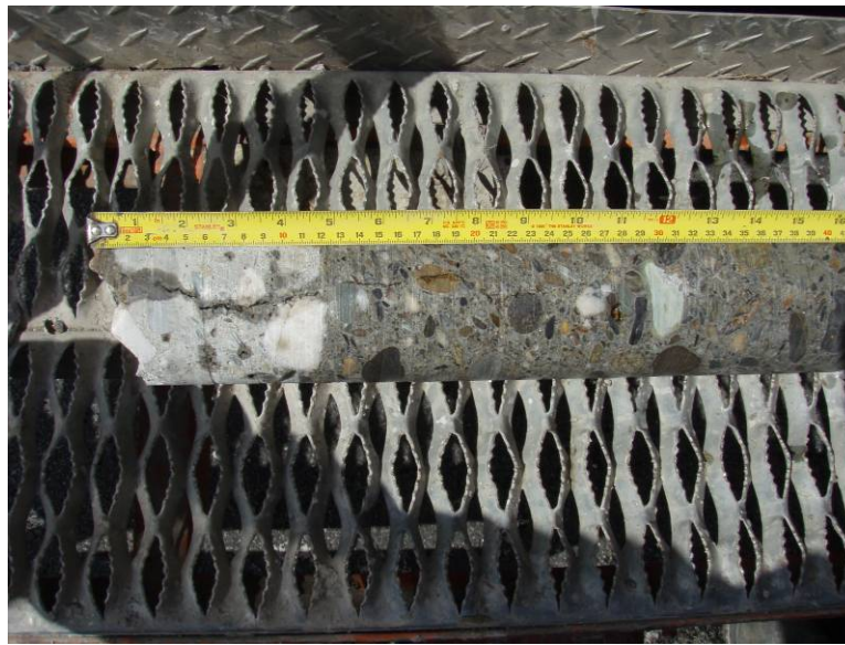
Figure 3.5 – Fissuration verticale dans une carotte prélevée dans la travée Nord
