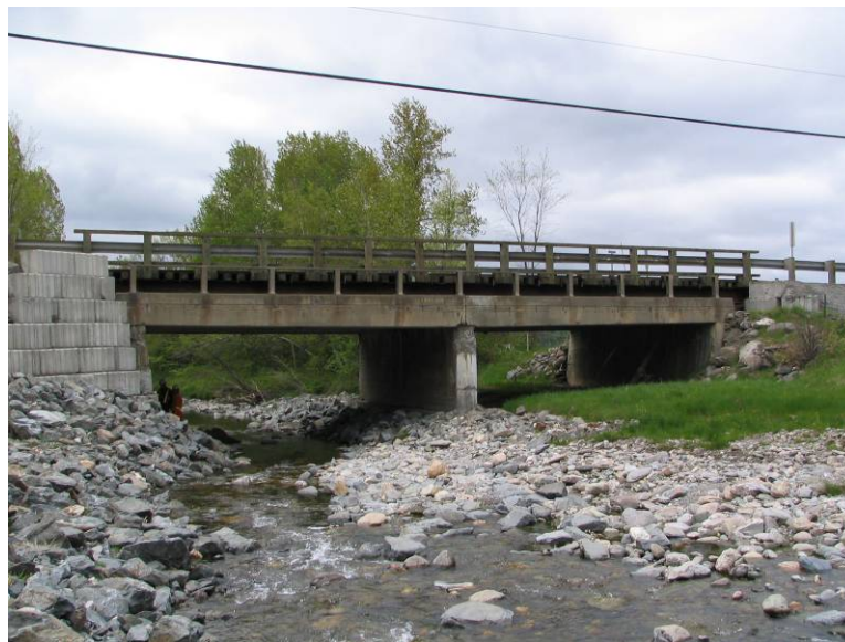
Figure 2.1 – Vue d'ensemble de l'ouvrage (Face amont)
