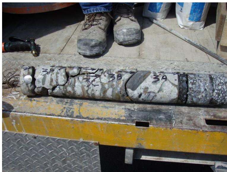
Figure 3.4 – Fissuration horizontale dans une carotte prélevée dans la travée Nord
