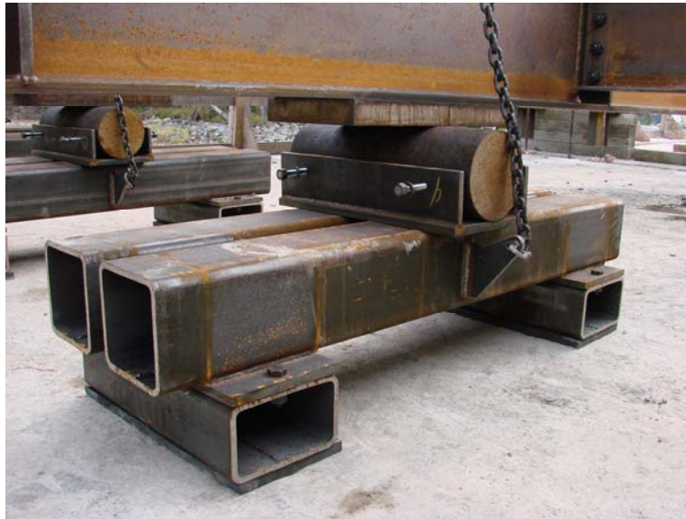
Figure 4.12 – Détail d'un chariot de chargement
