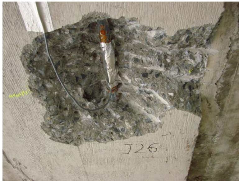
Figure 4.24 – Installation des jauges de déformation sur les barres d'armature de flexion
