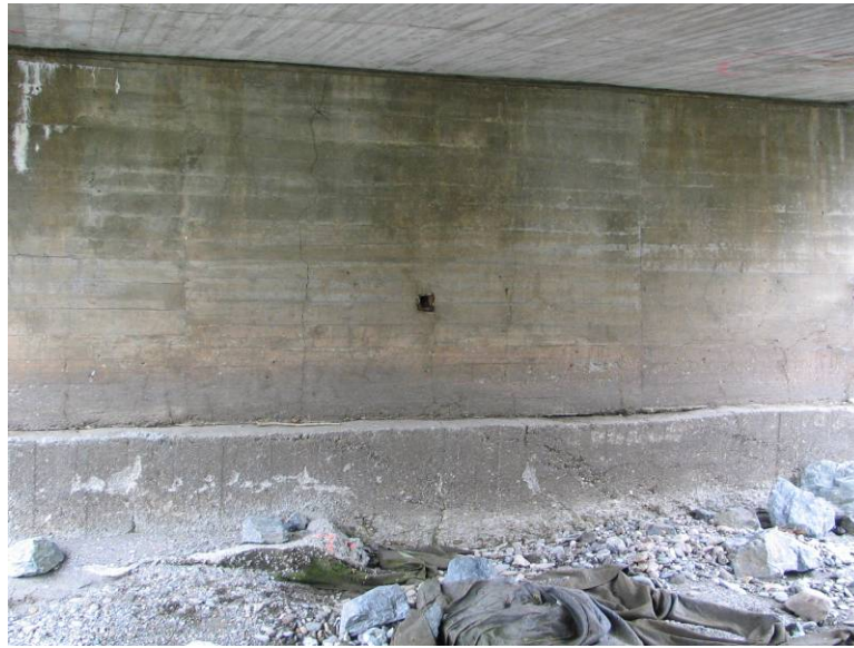
Figure 2.6 – Vue de la culée Sud
