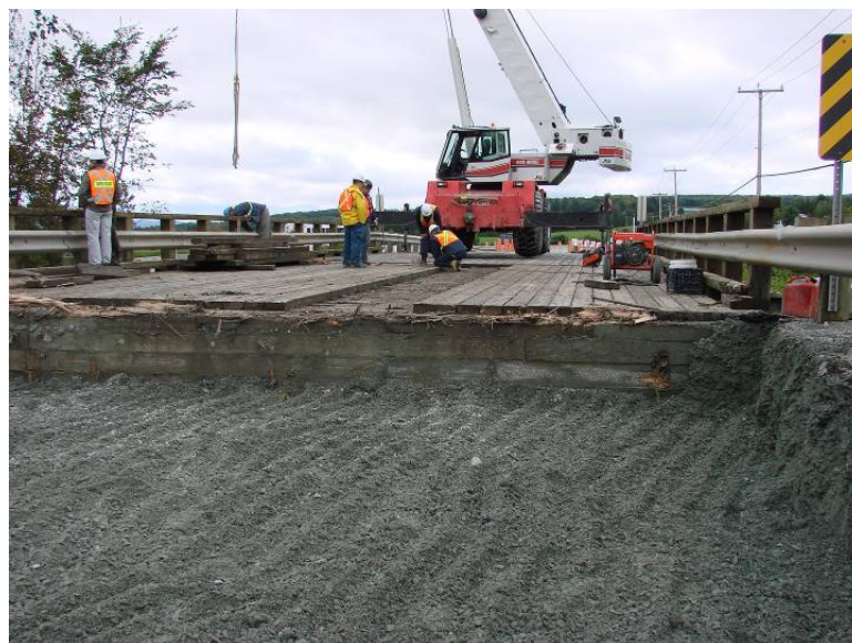
Figure 4.2 - Excavation de la rampe et enlèvement du platelage
