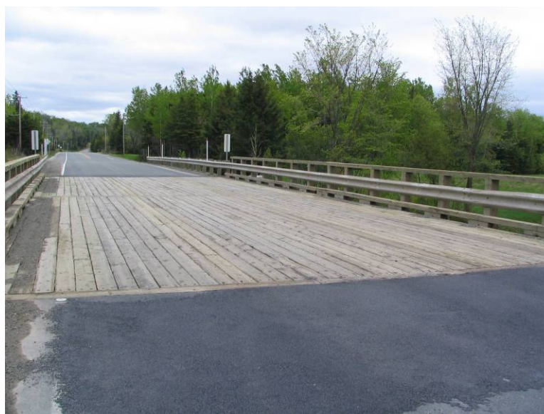
Figure 2.10 – Pont temporaire construit au-dessus du pont existant
