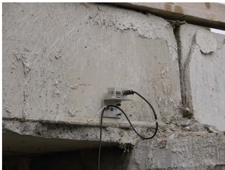
Figure 4.28 – Installation des inclinomètres (capteur de rotation)
