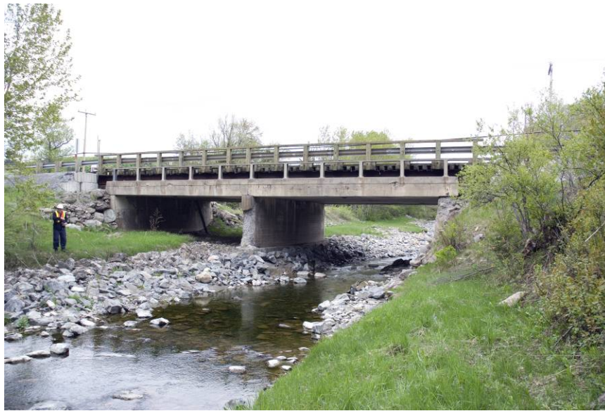
Figure 2.2 – Vue d'ensemble de l'ouvrage (Face aval)
