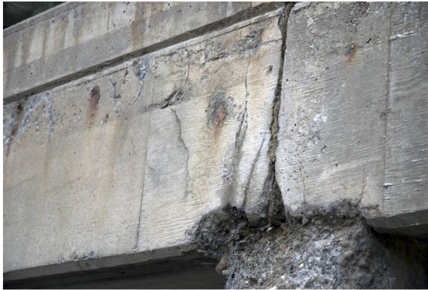
Figure 3.8 – Appui sur la pile
