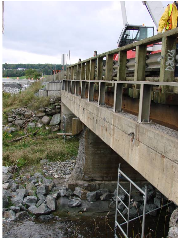
Figure 4.1 - Enlèvement de l'ouvrage temporaire placé sur la dalle de béton
