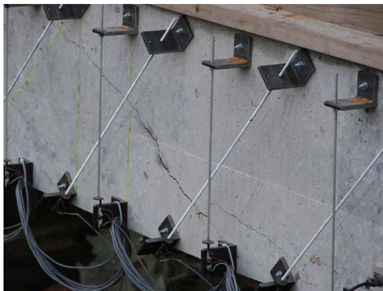
Figure 4.23 - Fixation des capteurs LVDT sur le côté de la dalle de béton
