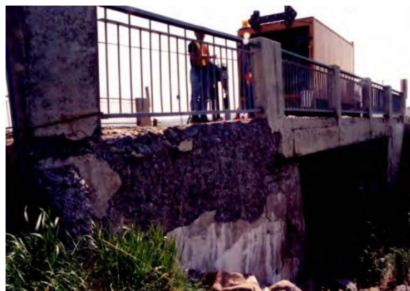
Vue générale côté amont direction sud
