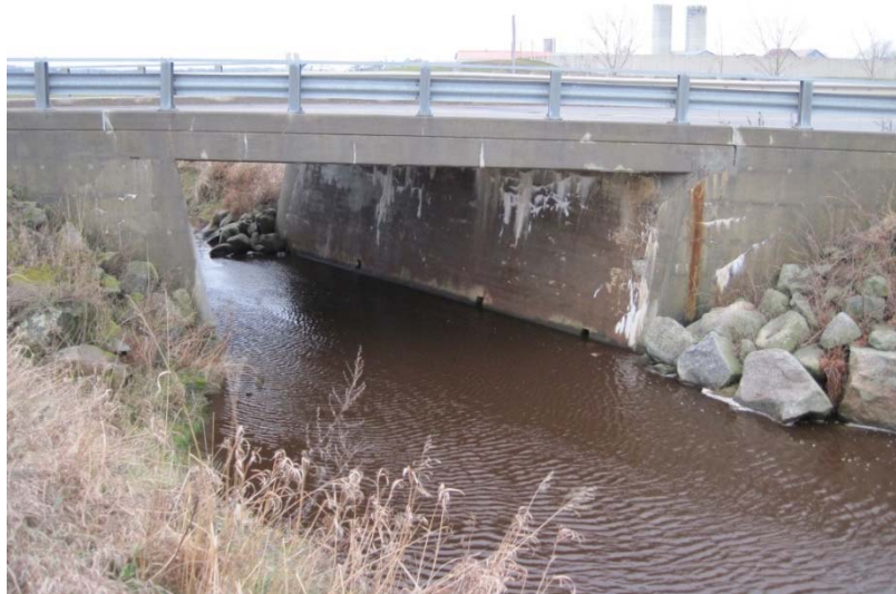
Figure 2.8 – Vue d'ensemble de l'ouvrage (Côté aval, décembre 2011)
