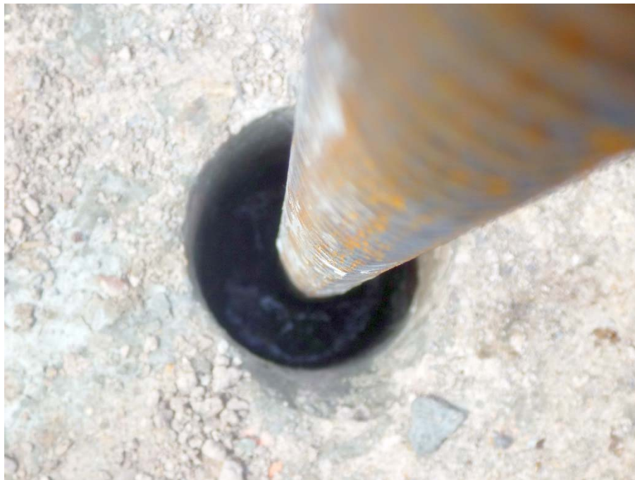
Figure 4.11 – Installation des barres d'ancrage
