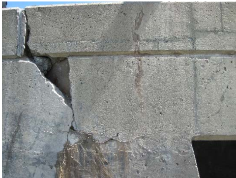
Vue culée nord côté amont
