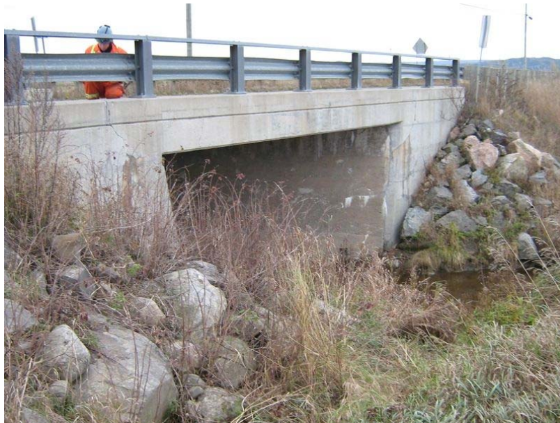
Figure 2.9 – Vue d'ensemble de l'ouvrage (Côté amont, octobre 2008)
