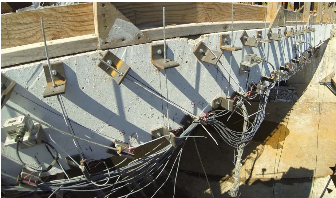
Figure 4.16 - Fixation des capteurs LVDT sur le côté de la dalle de béton, coin sud-est
