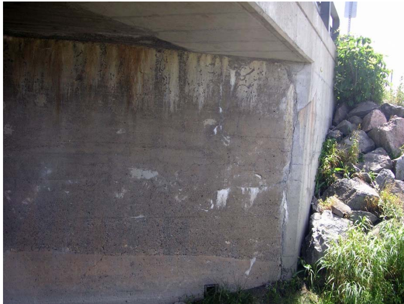
Figure 2.10 – Mise en évidence de l'élargissement d'extrémité - Vue de la culée Sud côté amont (juillet 2013)
