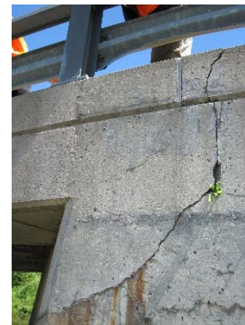
Vue culée sud côté amont
