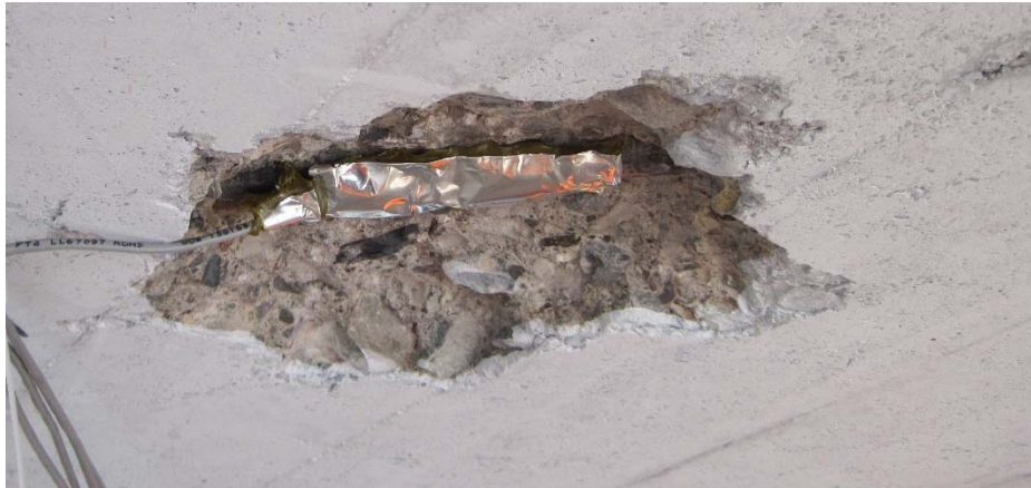
Figure 4.17 – Installation des jauges de déformation sur les barres d'armature de flexion
