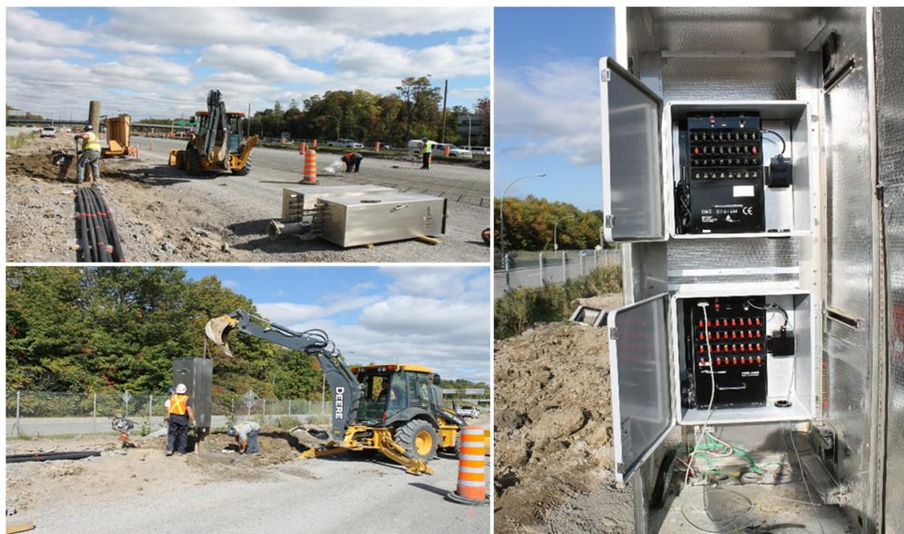
Figure 3.8 – Installation du coffret d'instrumentation
