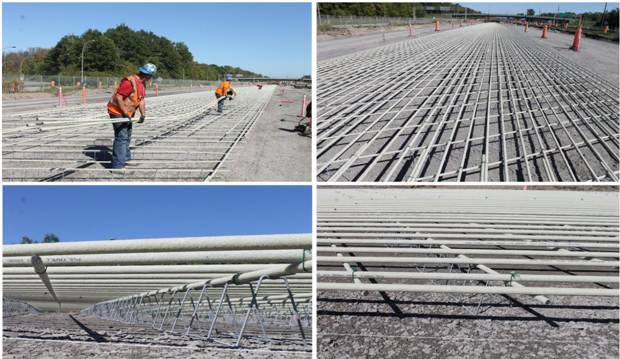
Figure 3.5 – Installation des barres d'armature en PRFV
