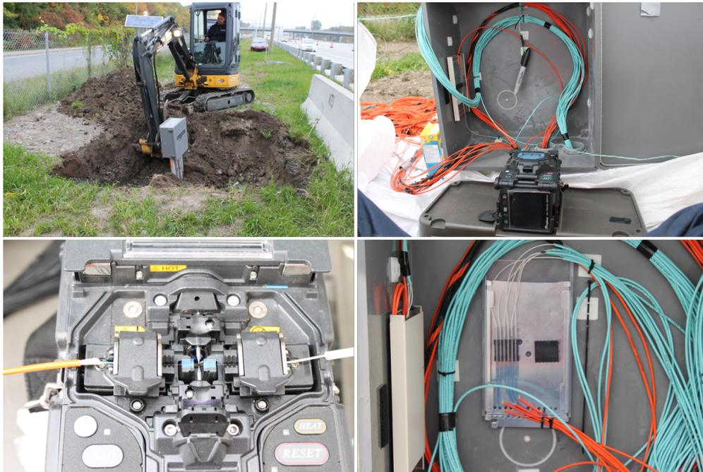
Figure 3.16 – Soudure des fibres optiques brisées
